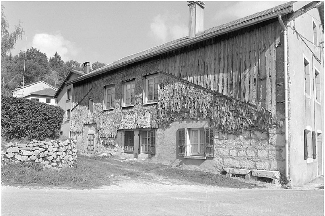
Façade d'une ancienne ferme retournée à Montépile.
