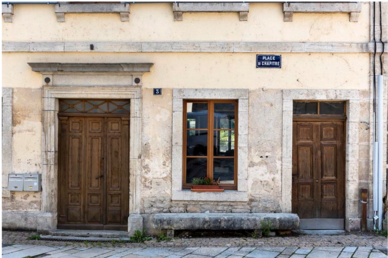
Immeuble 3 place du Chapitre, façade antérieure : entrée.
