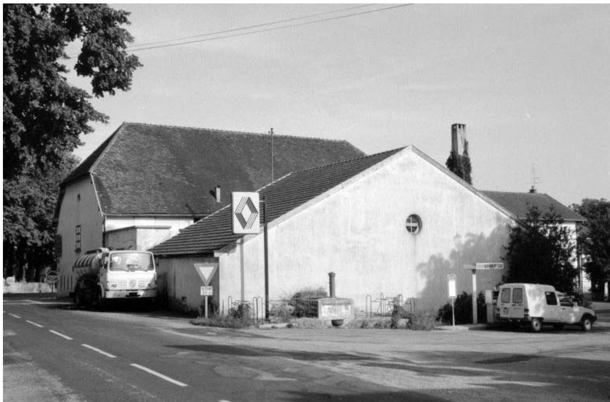
Fromagerie et pièce d'affinage vues du nord-ouest.
