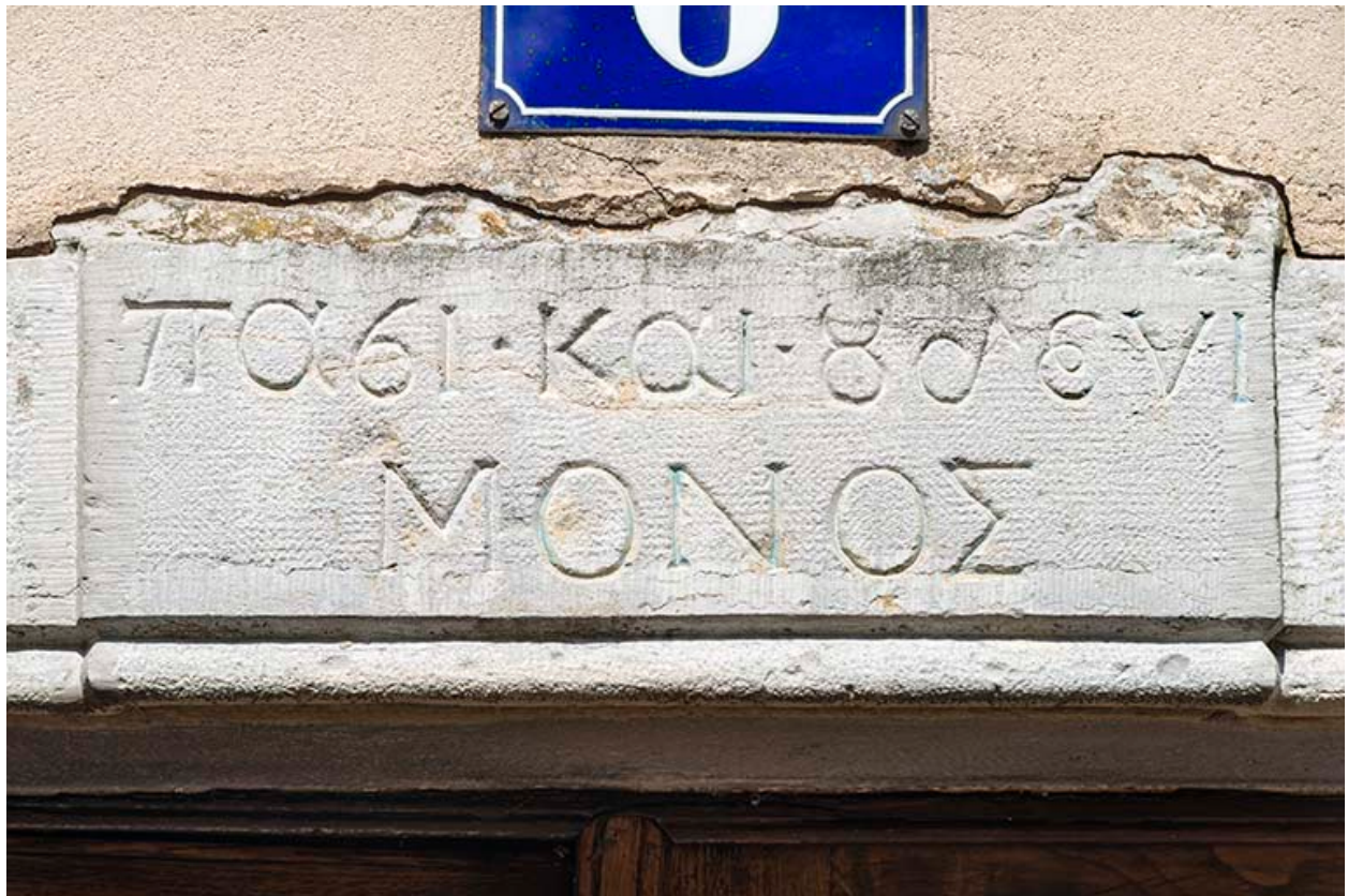
Façade sur rue. Linteau gravé.
