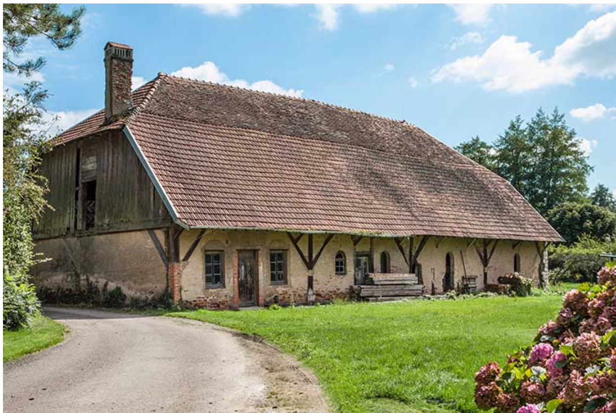
Magasin industriel depuis le nord-ouest.
