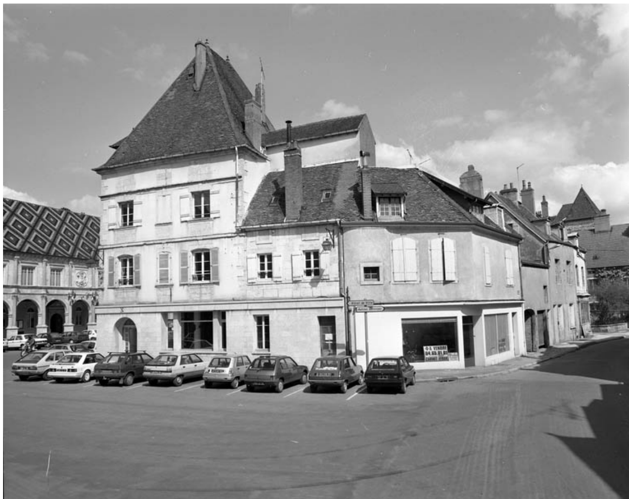
Façade latérale droite.
