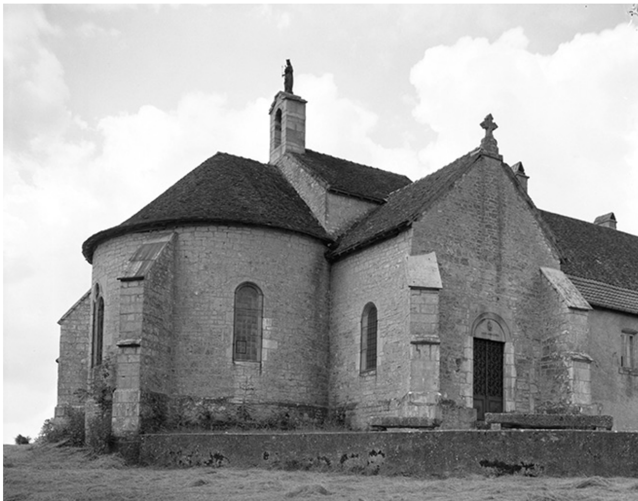
Extérieur : chœur et façade latérale gauche.
