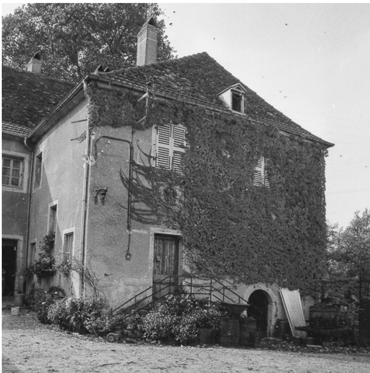
Ferme située rue des Enclos.
