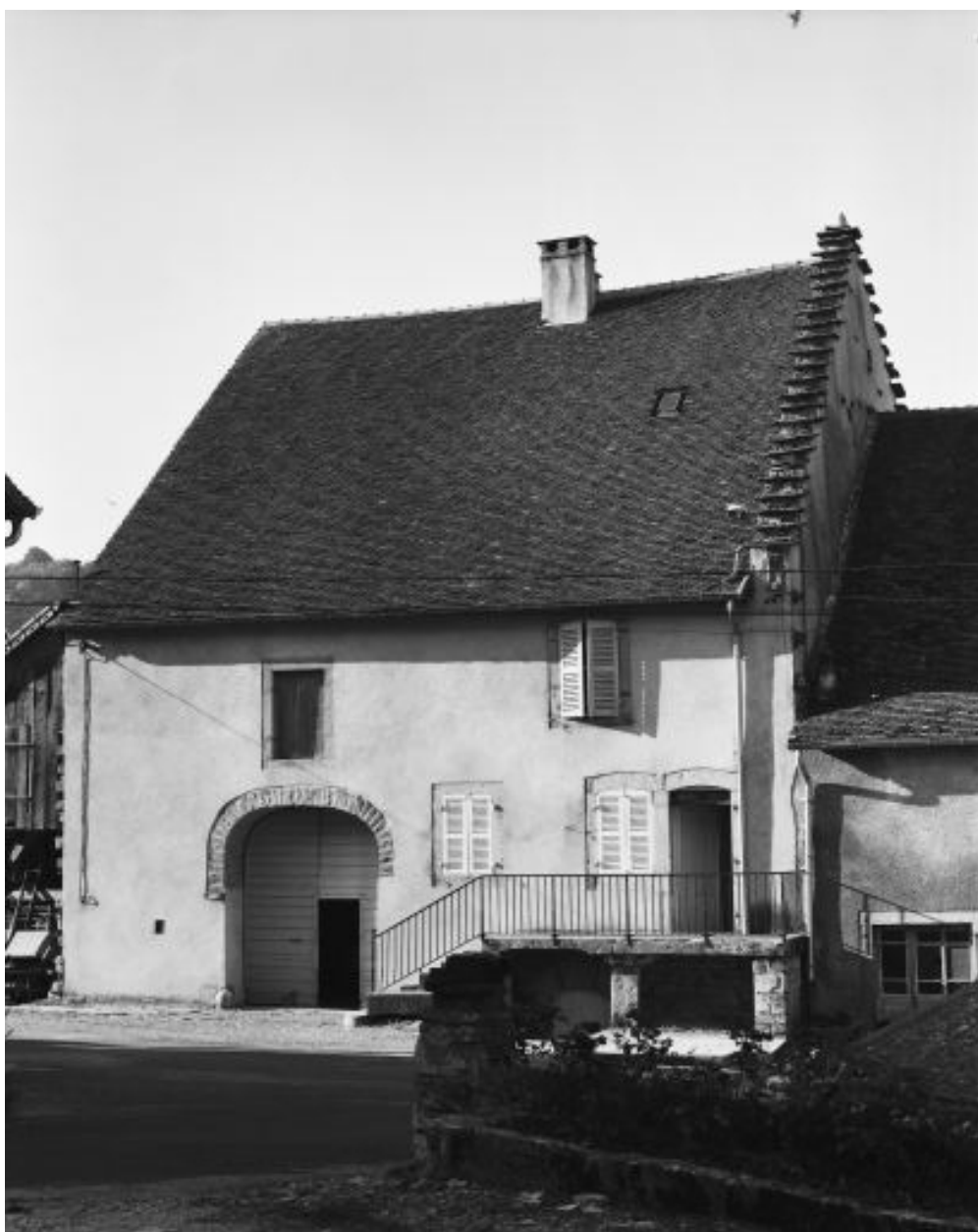
Façade antérieure vue de face.
