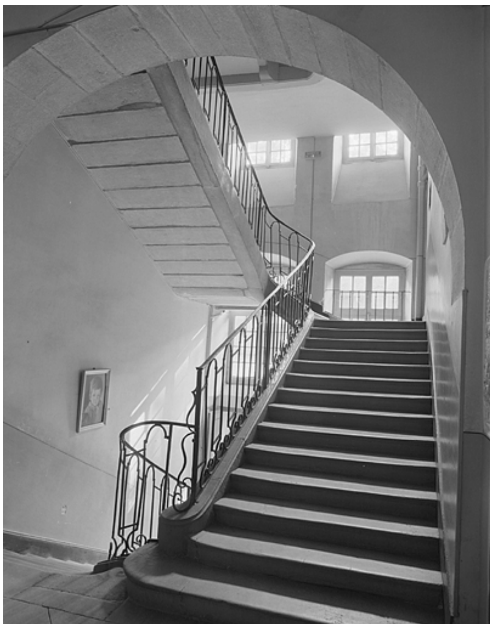
Bâtiment principal, escalier.
