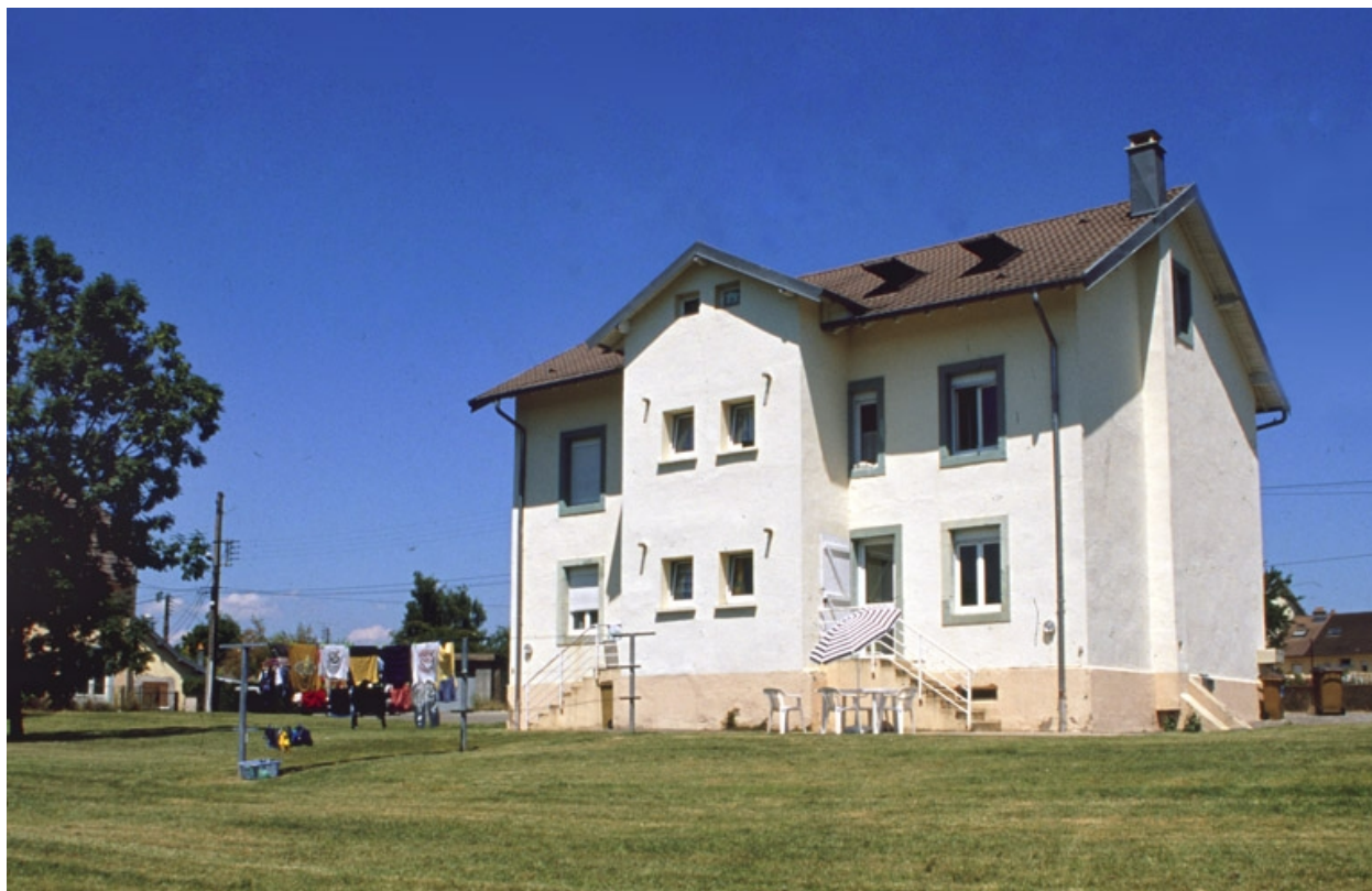
Façade postérieure d'un logement ouvrier.
