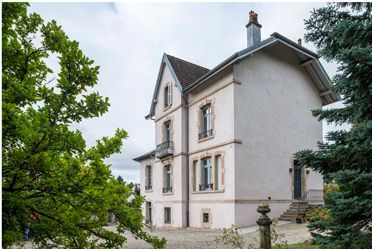
Le mur pignon nord.
