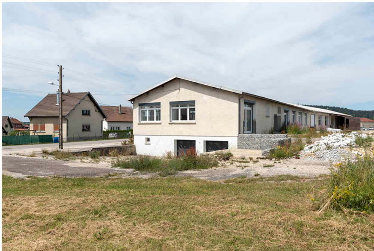
Façades postérieure et latérale droite.
