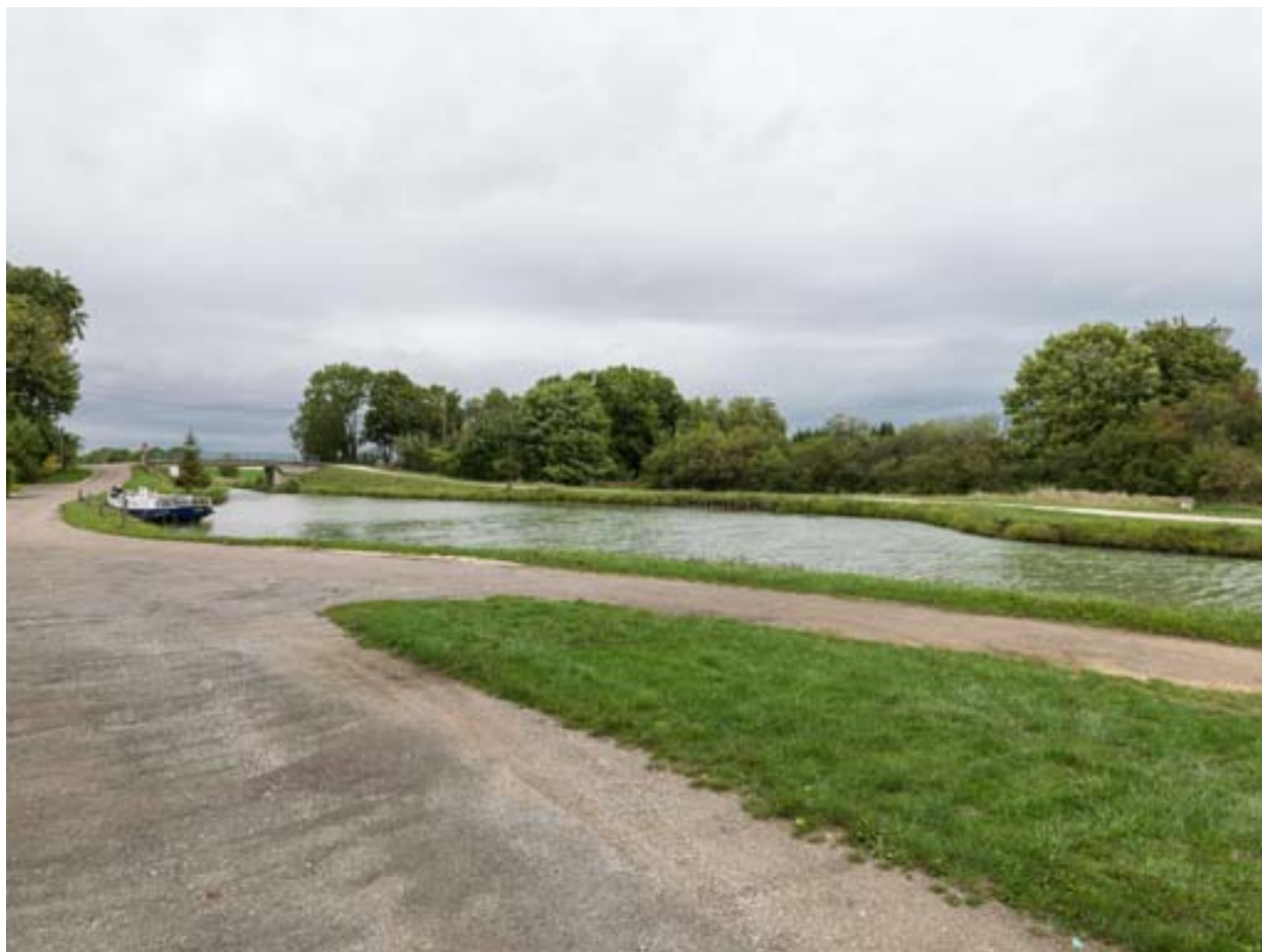
Vue d'ensemble de la gare d'eau.
