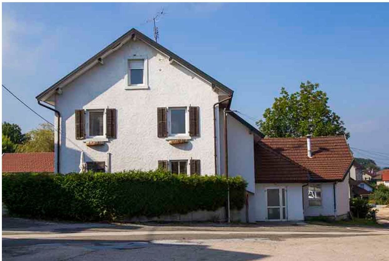
Logement patronal : façade latérale droite.
