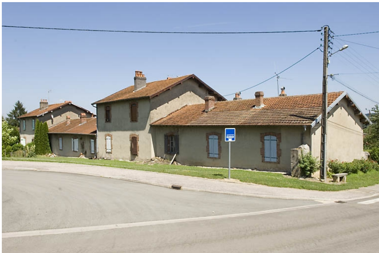
Logements ouvriers contigus. Vue depuis le sud.
