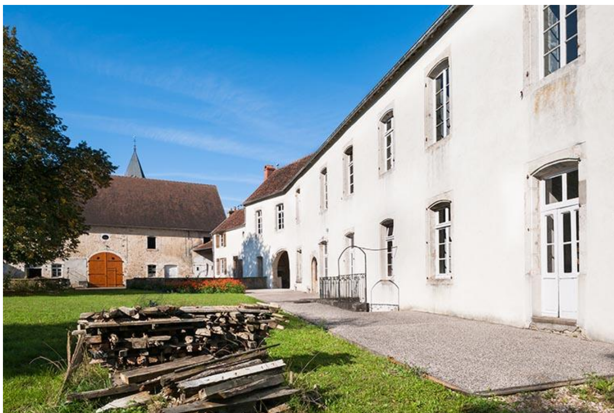
Vue d'ensemble sud-est
