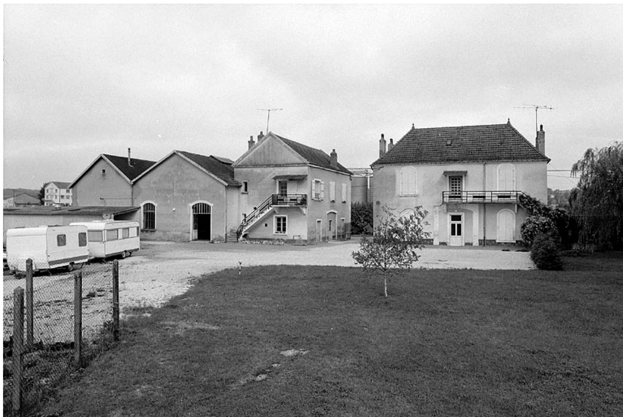
L'usine à gaz : façades postérieures.
