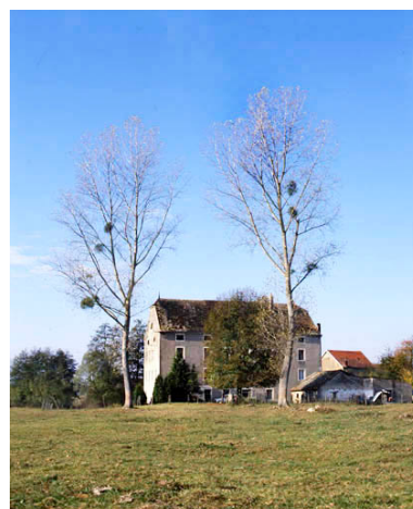
Vue d'ensemble depuis le sud en 1988. Phot. Yves Sancey IVR43_19857000140XA
