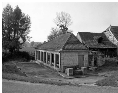
Façades postérieures depuis la cour en 1988. Phot. Yves Sancey IVR43_19857000014X
