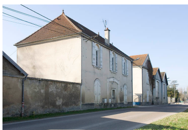
Vue d'ensemble depuis le quai Mavia. Phot. Jérôme Mongreville IVR43_20097000204NUC2A
