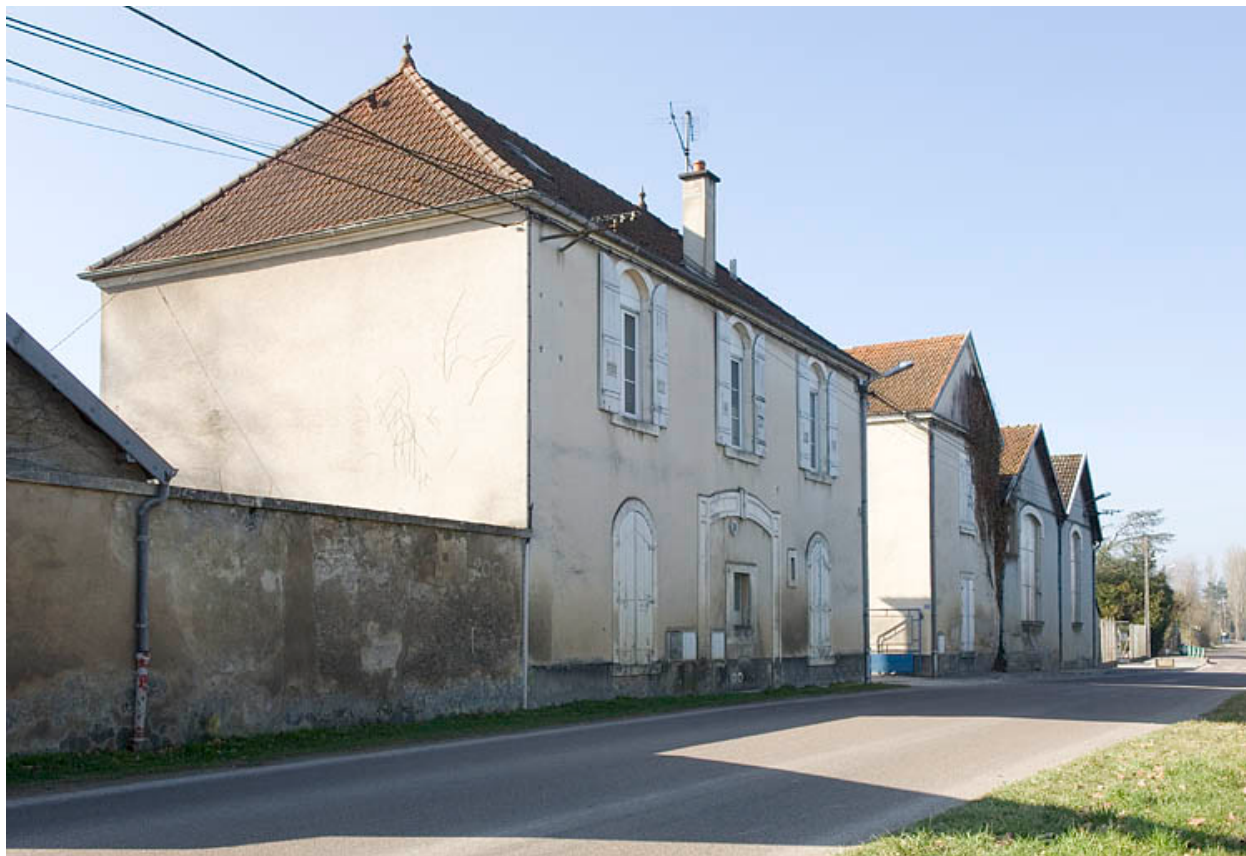
Vue d'ensemble depuis le quai Mavia.
