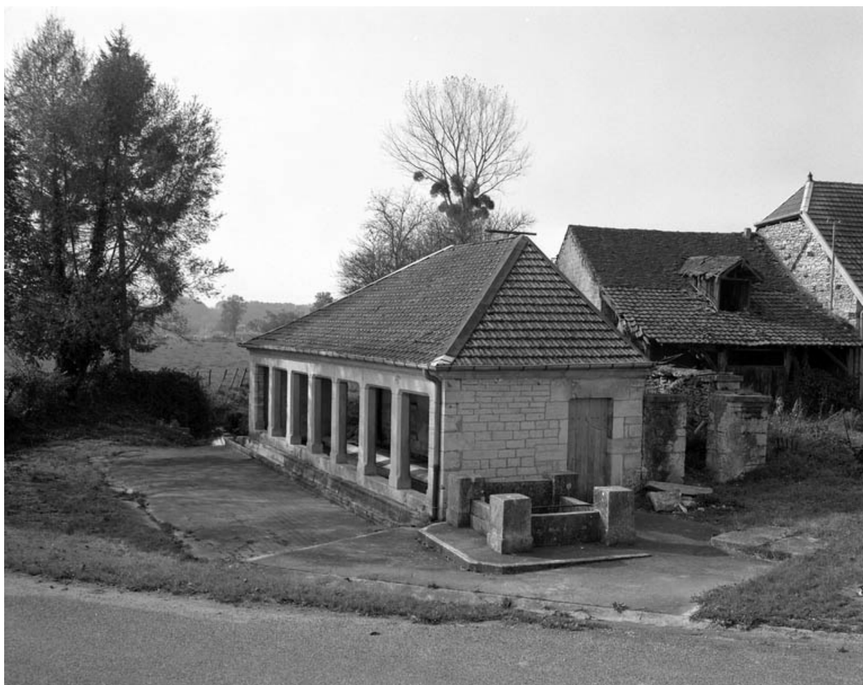
Façades postérieures depuis la cour en 1988.
