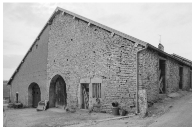
Ferme située ruelle des Voeux. Phot. Bernard Lardière IVR43_19797000288Z
