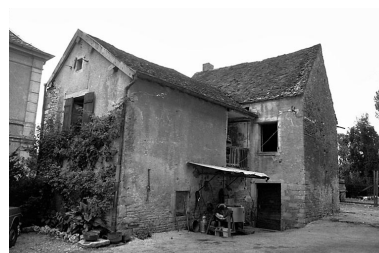
Maison située rue du Touillon. Phot. Bernard Lardière IVR43_19797000280Z
