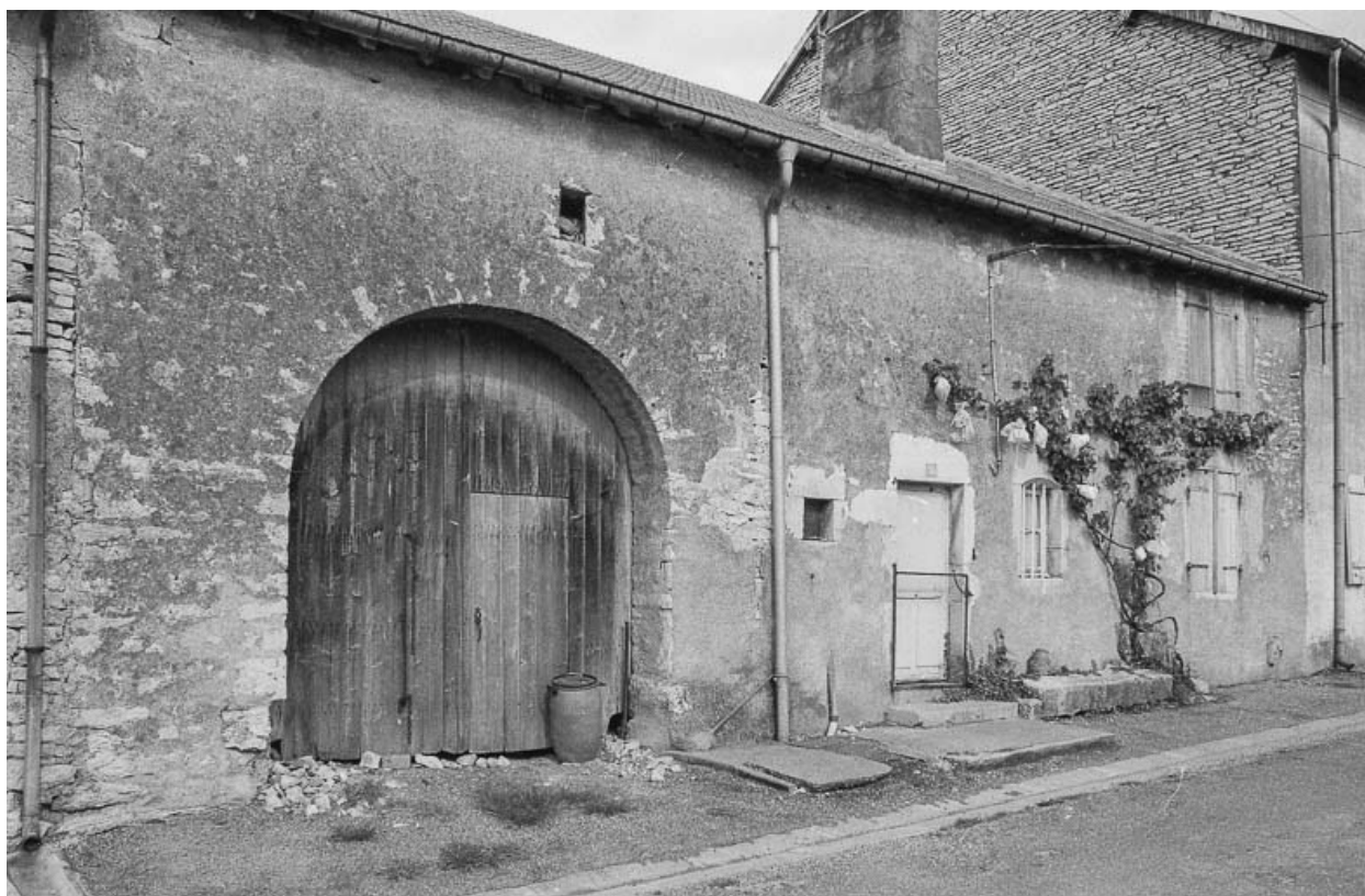
Ferme située rue des Douches.
