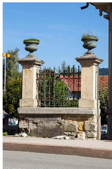
Mur de clôture côté rue de la Louhière. Phot. Yves Sancey IVR43_20132502291NUC2A
