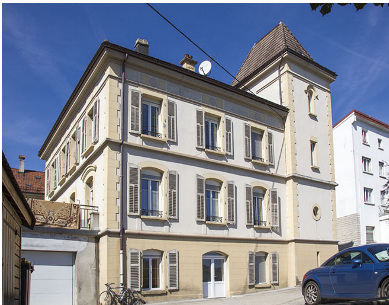
Façades postérieure et latérale droite.
