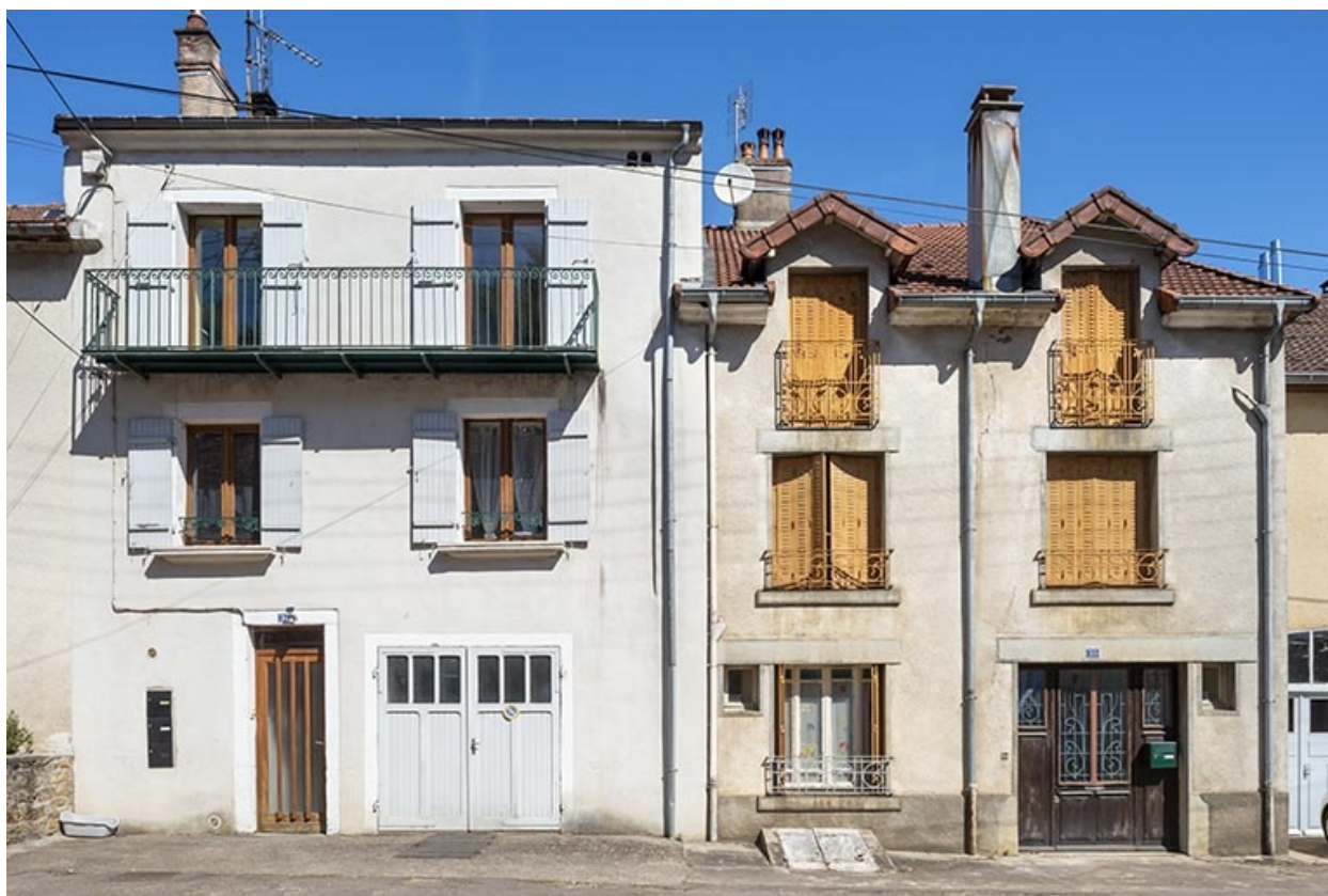
Rue Thiers, façades des maisons n° 31 et 33.
