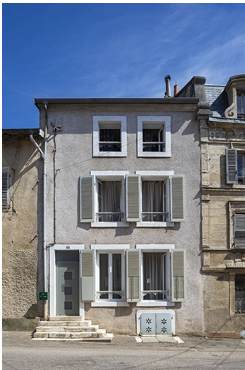
Rue Thiers, façade de la maison n° 22.
