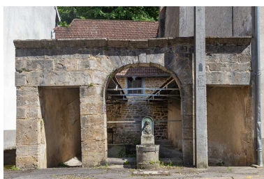
Rue Thiers, la fontaine- lavoir dite de la Jacquemotte. Phot. Jérôme Mongreville IVR43_20217000328NUC4A
