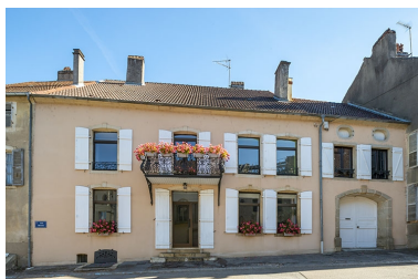
Rue Thiers, n° 2. Phot. Jérôme Mongreville IVR43_20217000680NUC4A
