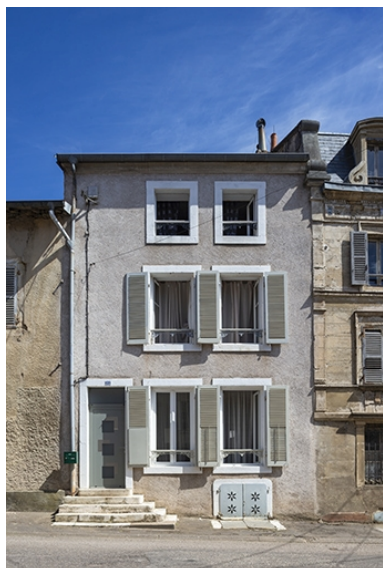
Rue Thiers, façade de la maison n° 22.
