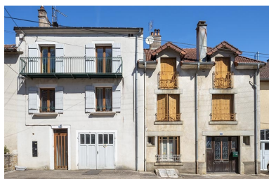
Rue Thiers, façades des maisons n° 31 et 33.
