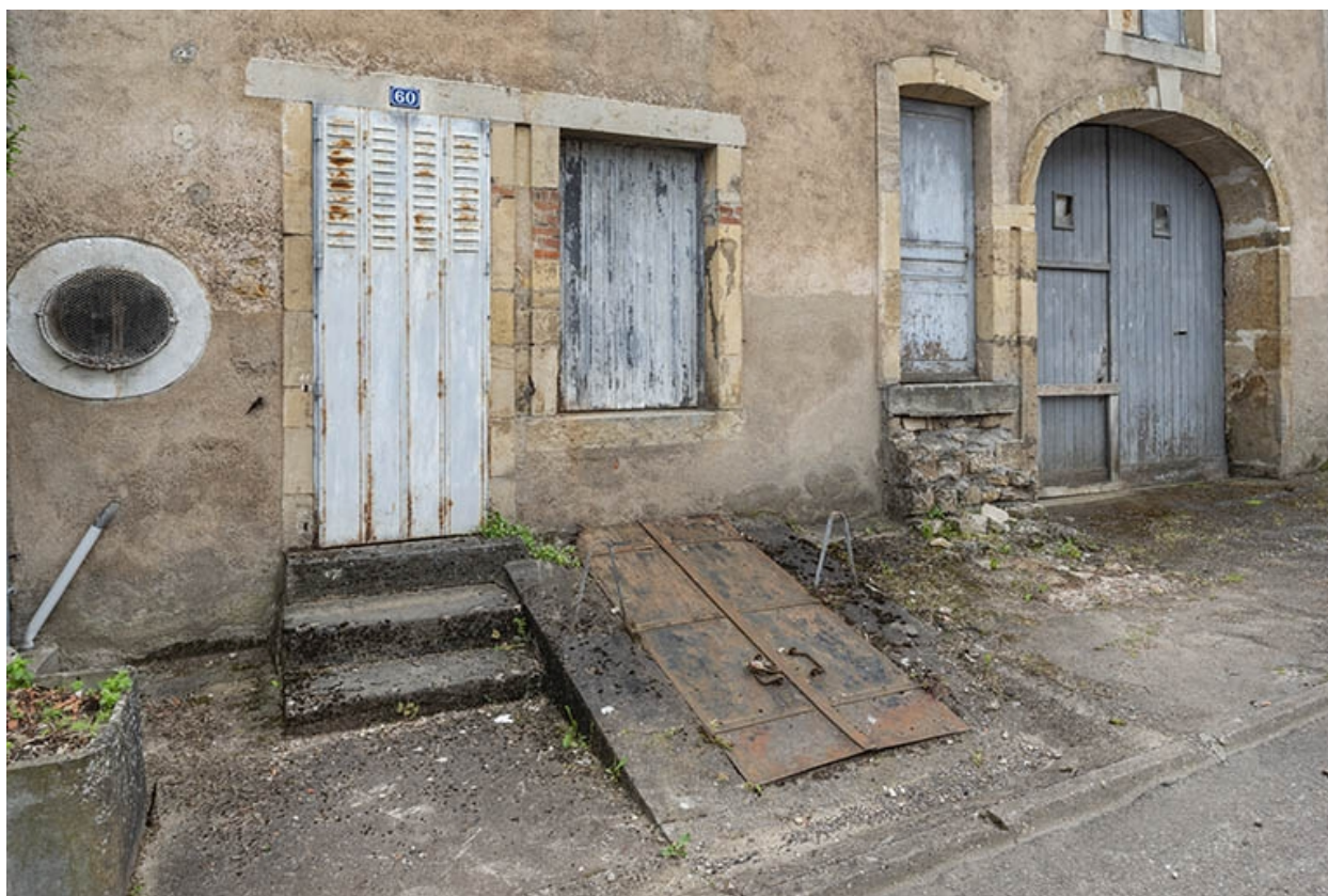
Rue Thiers, rez-de-chaussée du n° 60.
