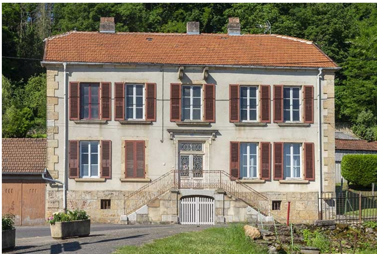
Rue Thiers, façade de la demeure n° 106.
