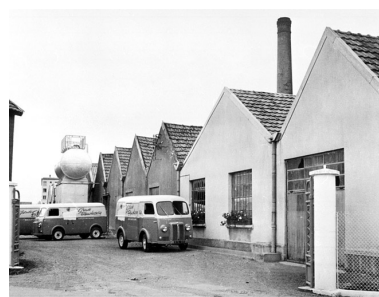
Pignons ouest des ateliers depuis l'entrée. Phot. Jérôme Mongreville IVR43_20009000924X
