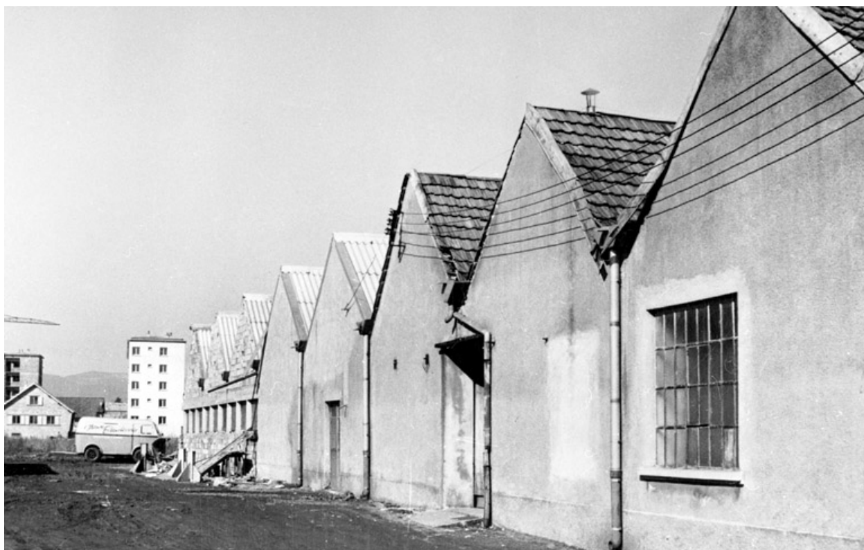
Extension nord de la blanchisserie.
