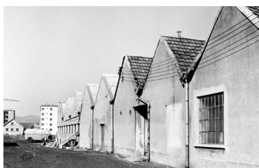
Extension nord de la blanchisserie. Phot. Jérôme Mongreville IVR43_20009000921X
