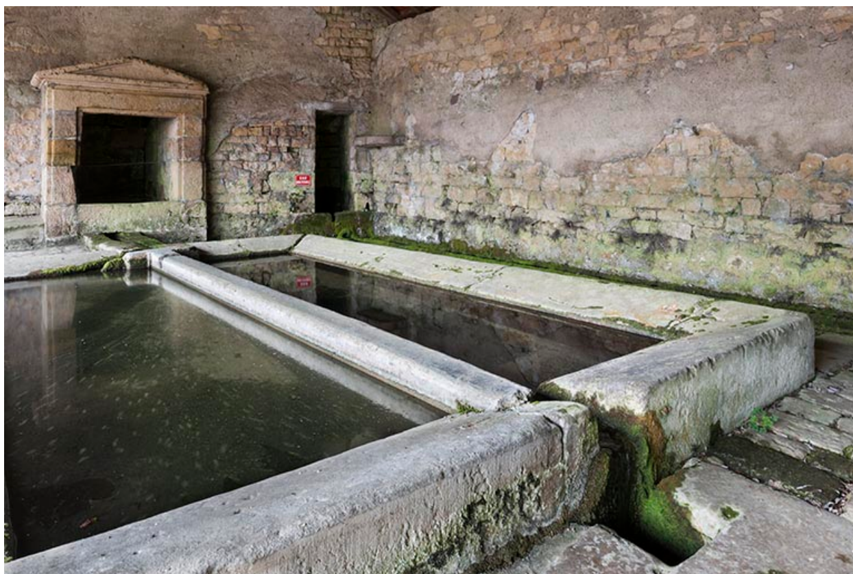
Détail des bassins.
