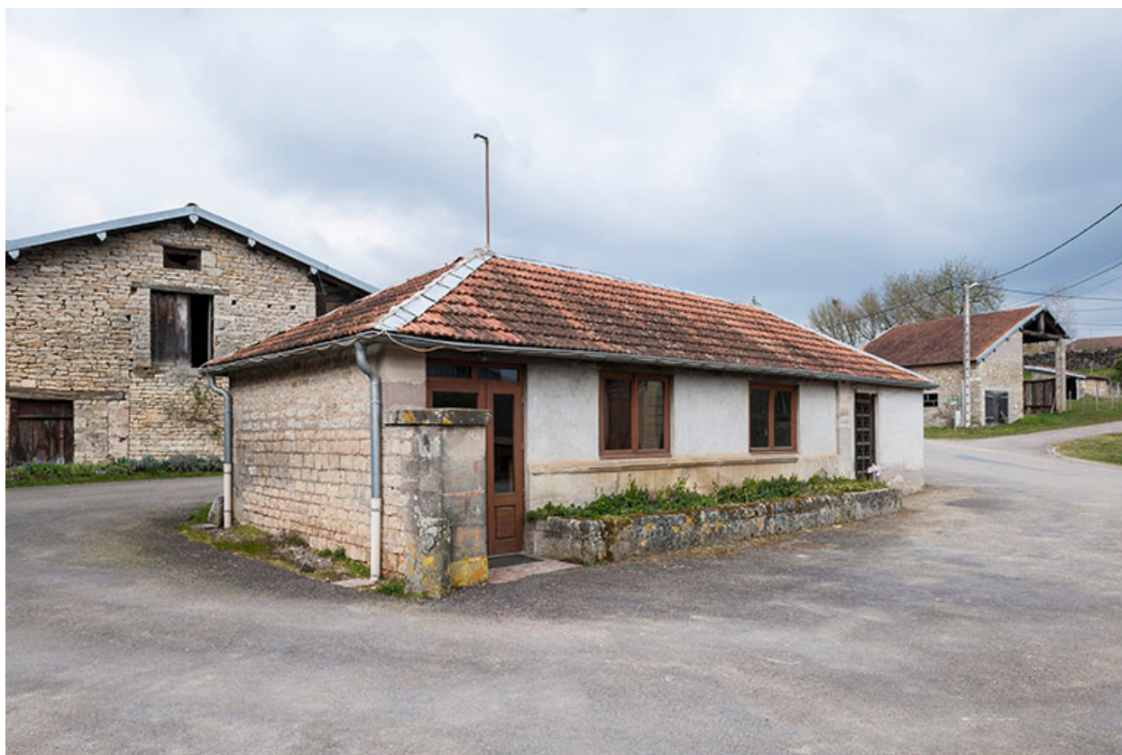
Le lavoir transformé en remise.
