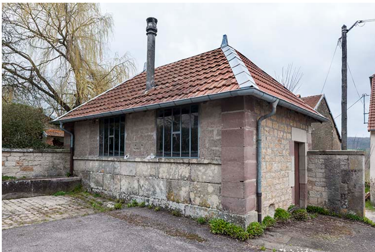
Le lavoir, transformé en local municipal.
