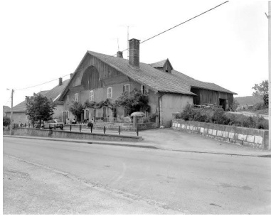
Façades antérieure et latérale droite.
