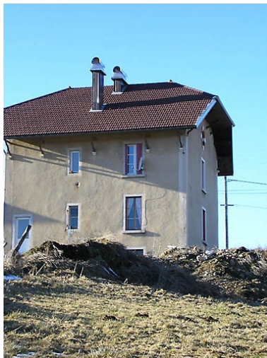
Façade postérieure. Phot. Marie-Pierre Reynet IVR43_20083900474NUC1A
