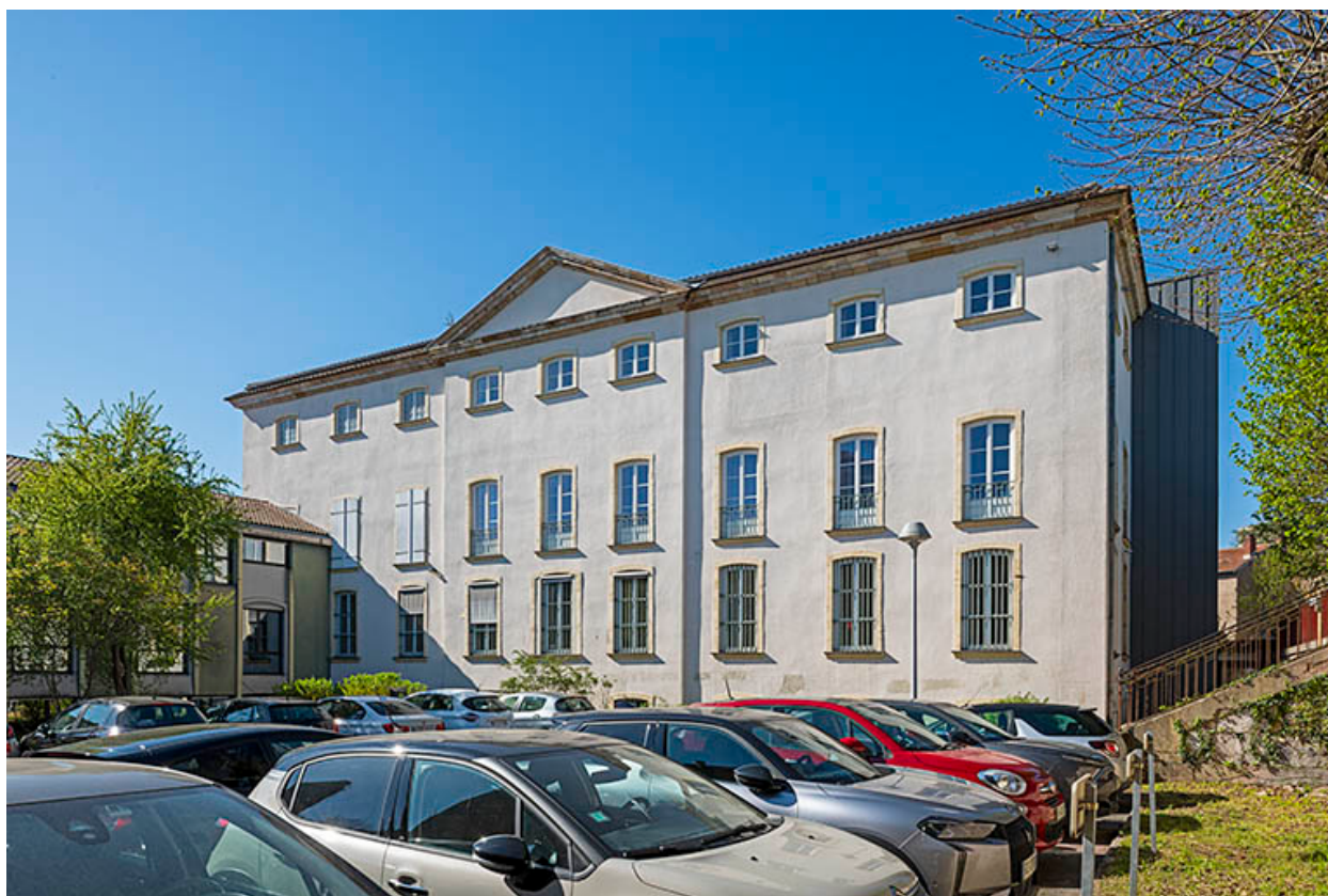
Façade nord-est de l'hôtel d'Igé.
