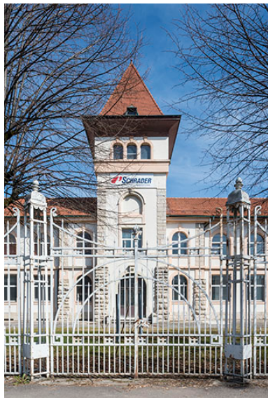
Avant-corps central du bâtiment administratif. Phot. Jérôme Mongreville IVR43_20172500326NUC4A
