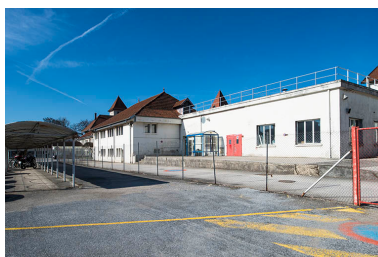
Vestiaires et infirmerie depuis la cour. Phot. Jérôme Mongreville IVR43_20172500320NUC4A
