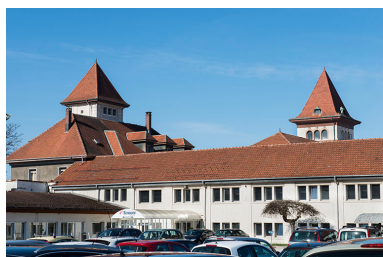
Bâtiments sud : conciergerie, bureaux, vestiaires. Phot. Jérôme Mongreville IVR43_20172500323NUC4A
