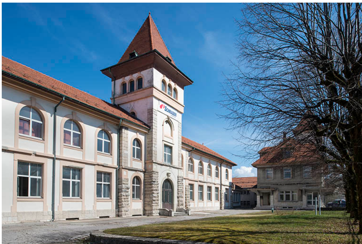
Bâtiment administratif depuis la cour sud.
