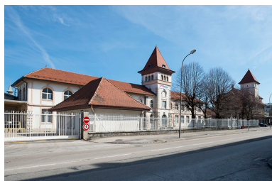
Bâtiments d'entrée, depuis l'ouest. Phot. Jérôme Mongreville IVR43_20172500325NUC4A
