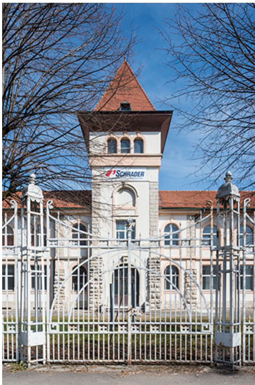
Avant-corps central du bâtiment administratif.
