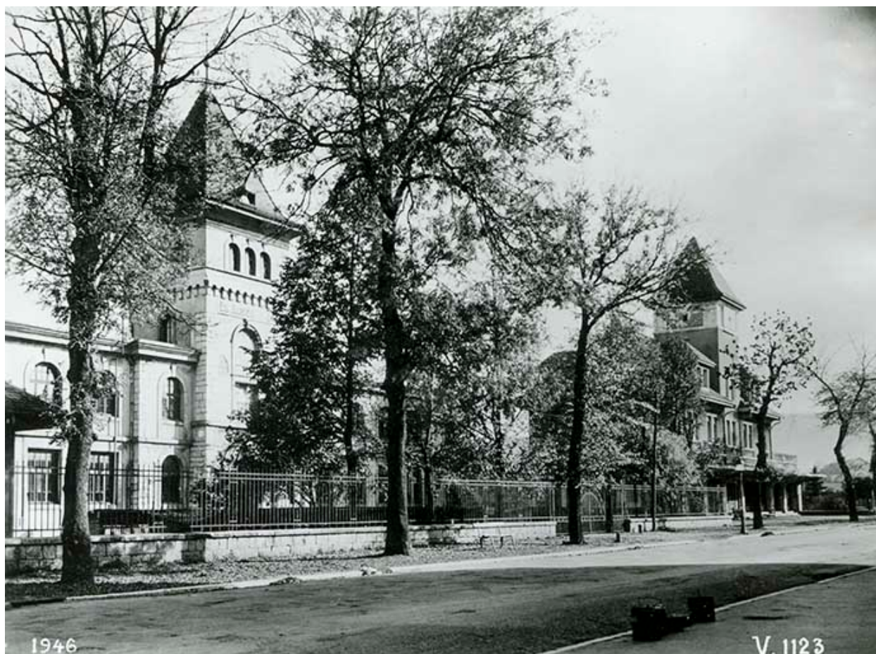
Façades ouest de l'usine, fotogr., s.d. [1946 ?].
