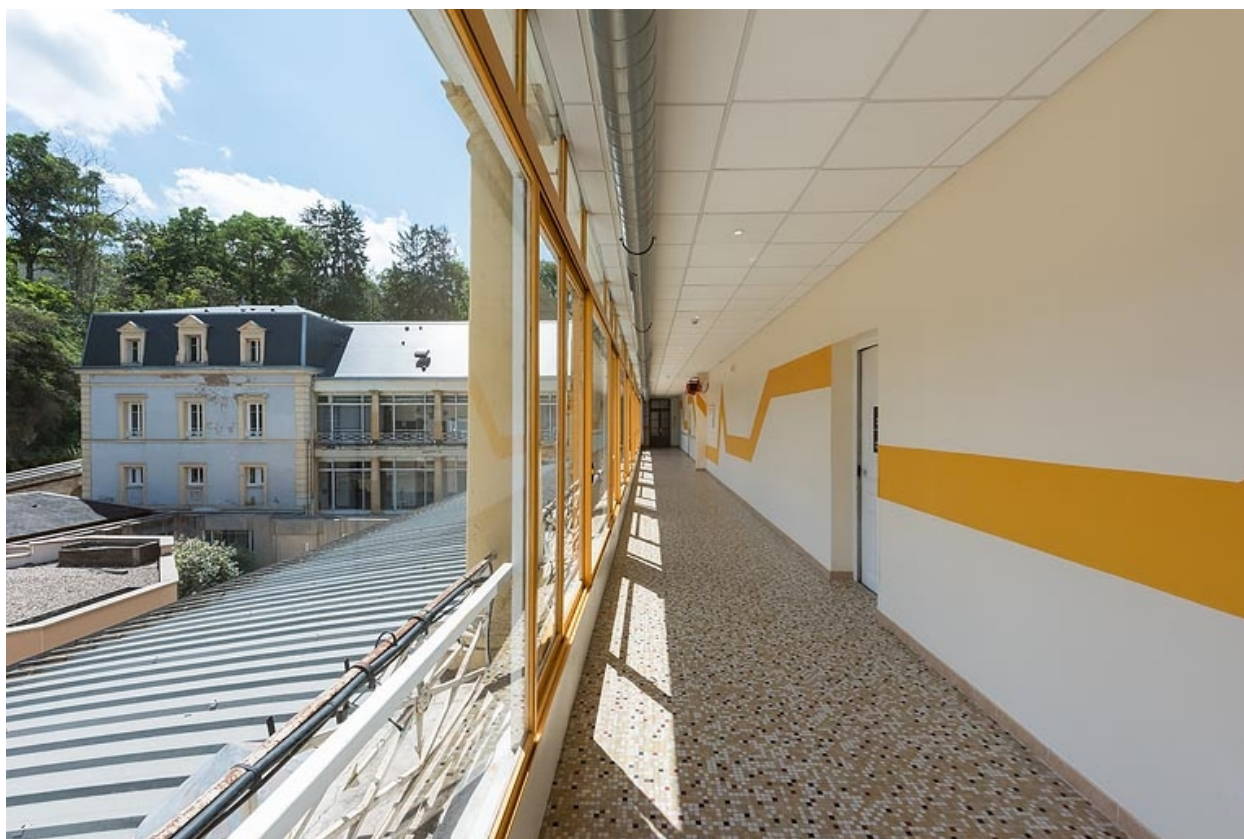
Galleries du deuxième étage.
