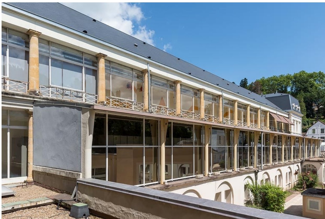
Extension récente devant la façade nord.
