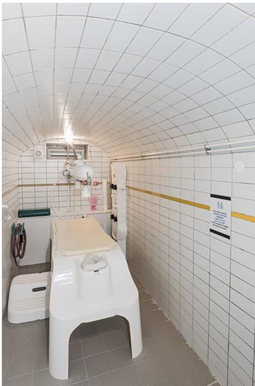
Nouvelle cabine de soin, au rez-de-chaussée.
