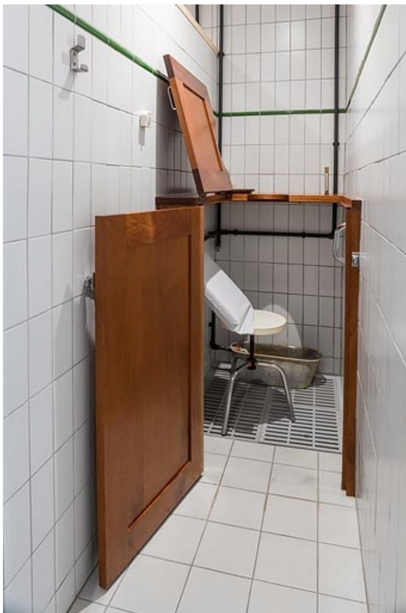
Étuves locales, au rez-de-chaussée (pavillon annexe de 1897).
