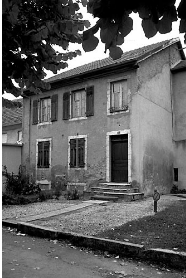
Vue d'ensemble. Phot. Bernard Lardière IVR43_19832500210Z
