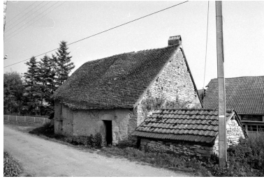
Façade sur rue. Phot. Bernard Lardière IVR43_19797000100Z
