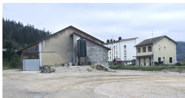
Entrepôt, depuis le nord (côté Andelot-en-Montagne).
