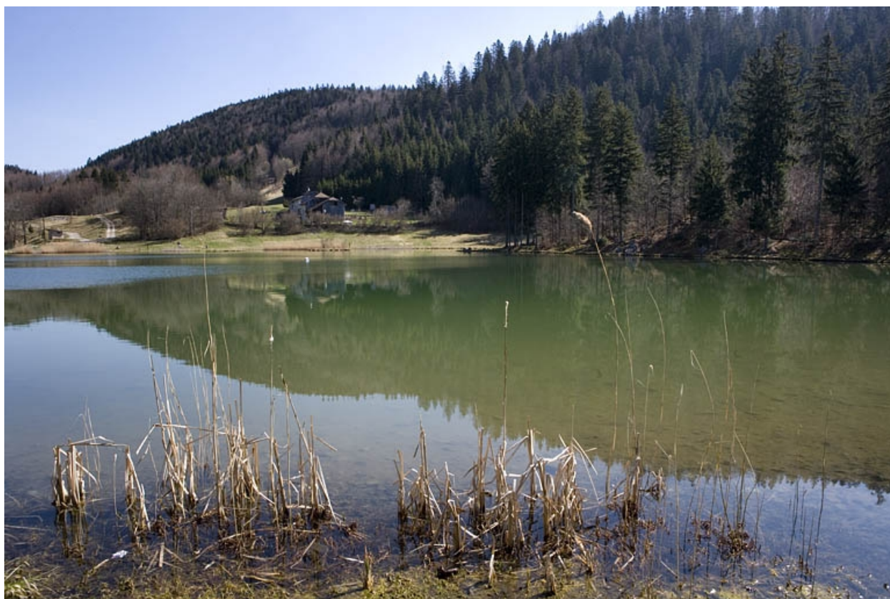
Réservoir : vue d'ensemble, depuis l'ouest.
