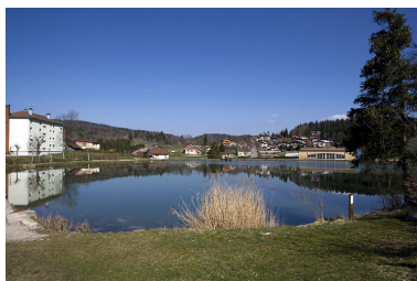
Réservoir : vue d'ensemble, depuis le sud.
