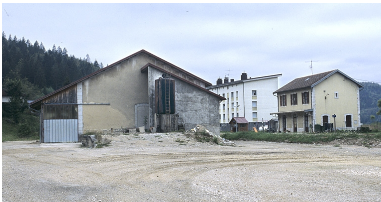
Entrepôt, depuis le nord (côté Andelot-en-Montagne).
