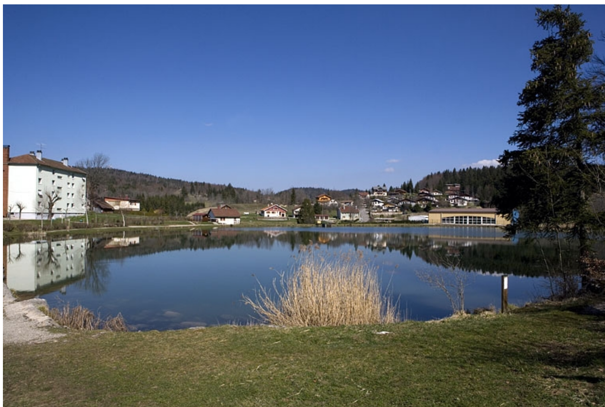
Réservoir : vue d'ensemble, depuis le sud.
