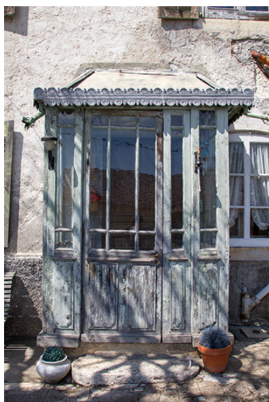
Façade antérieure : veranda. Phot. Yves Sancey IVR43_20132503005NUC2A
