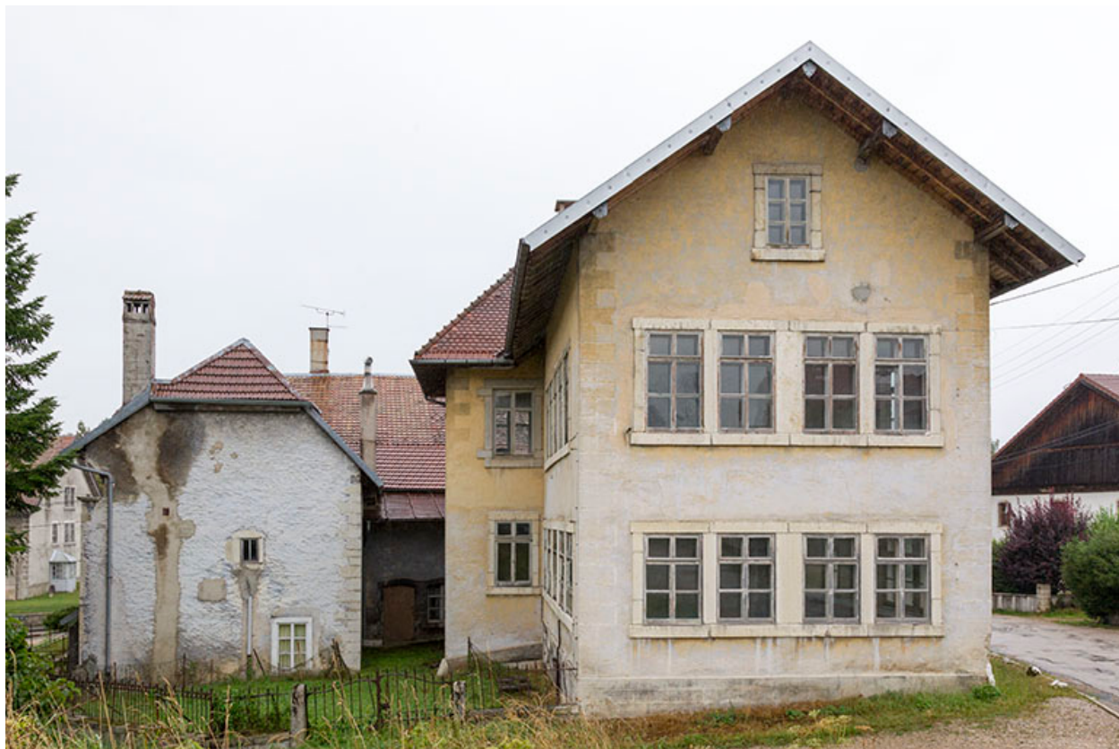
Usine : façade latérale gauche.
