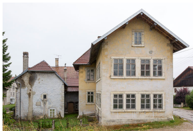
Usine : façade latérale gauche.
