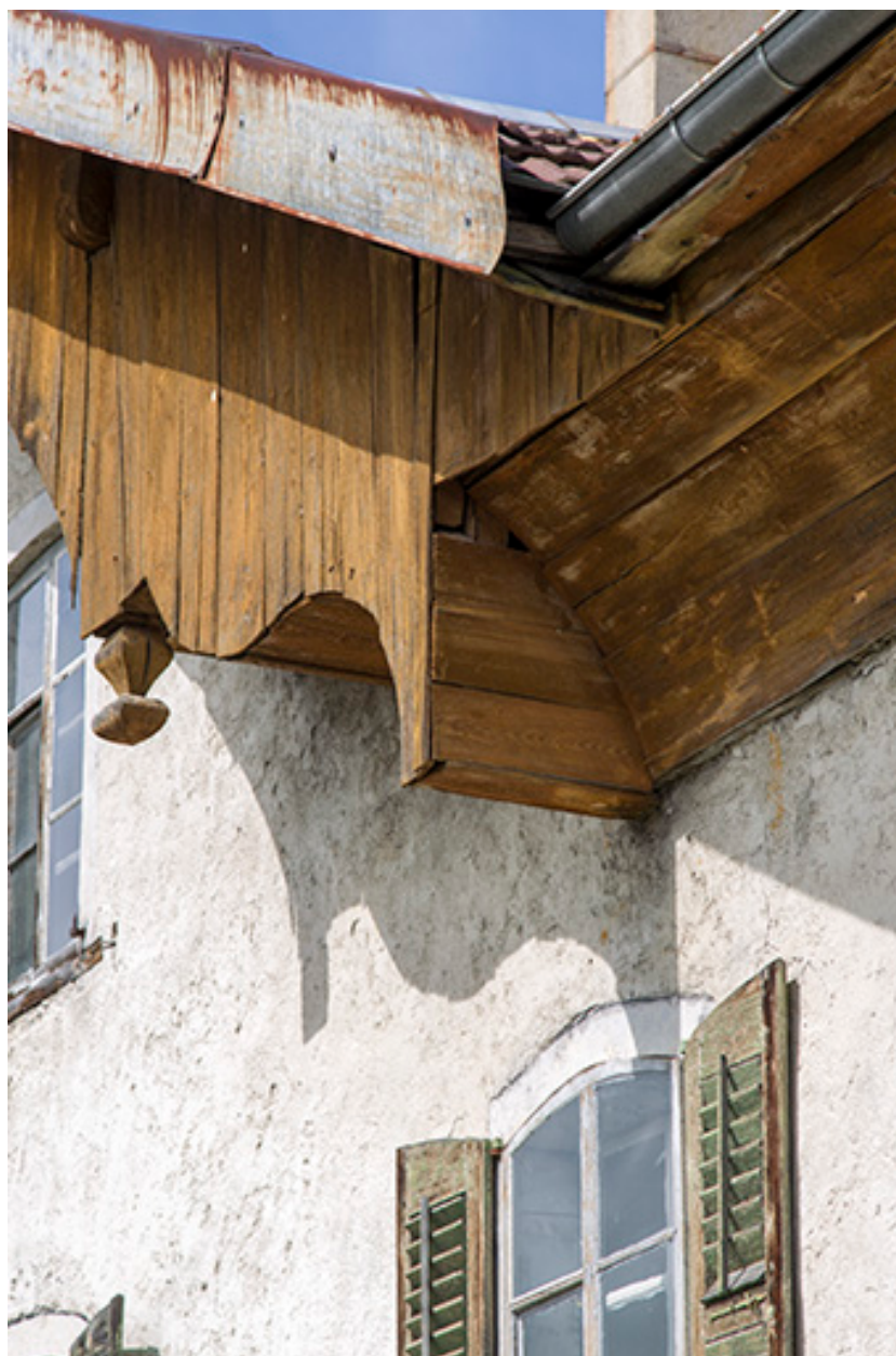
Façade antérieure : extrémité droite de la lambrichure et motif décoratif ornant l'extrémité pendante d'un poteau.
