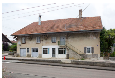
Façade latérale gauche.
