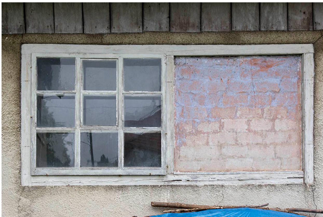
Façade latérale droite : fenêtres.
