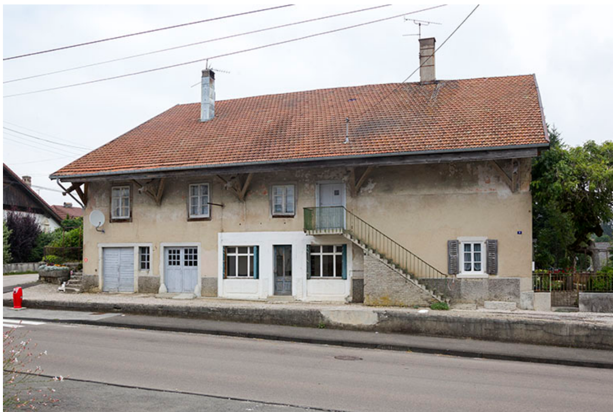
Façade latérale gauche.
