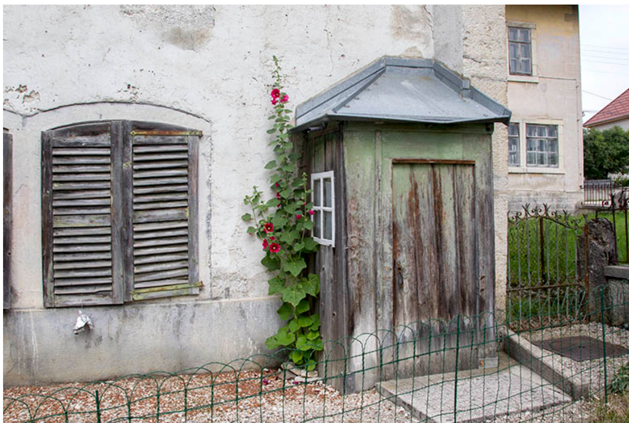
Façade antérieure : fenêtre du rez-de-chaussée et édicule.
