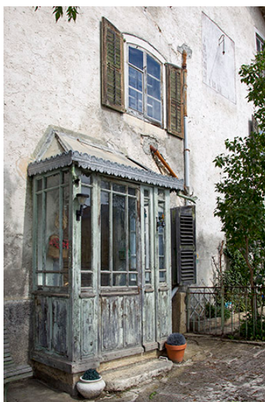
Façade antérieure : veranda, de trois quarts gauche. Phot. Sonia Dourlot IVR43_20152500795NUC2A
