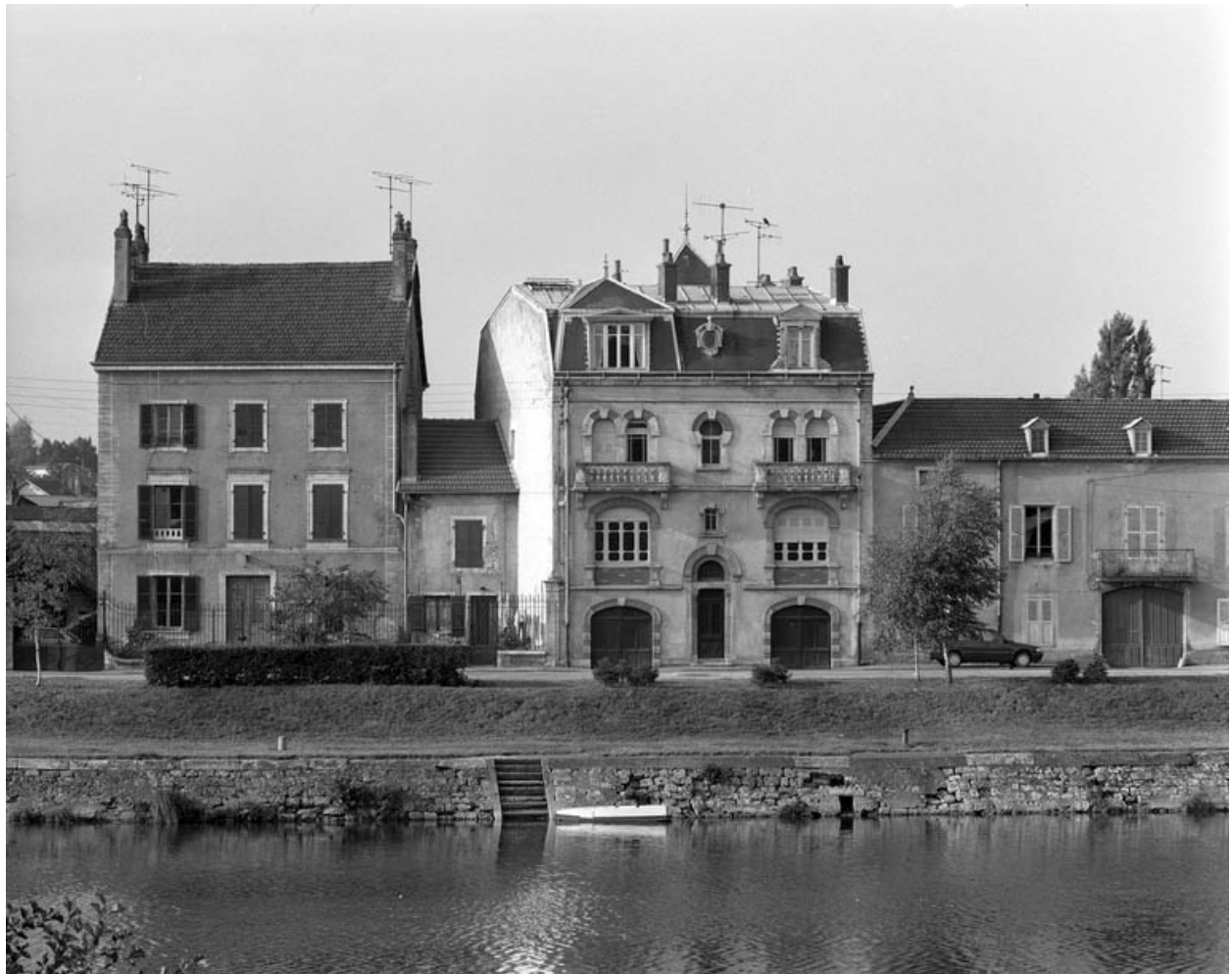
Vue d'ensemble depuis le quai Villeneuve.
