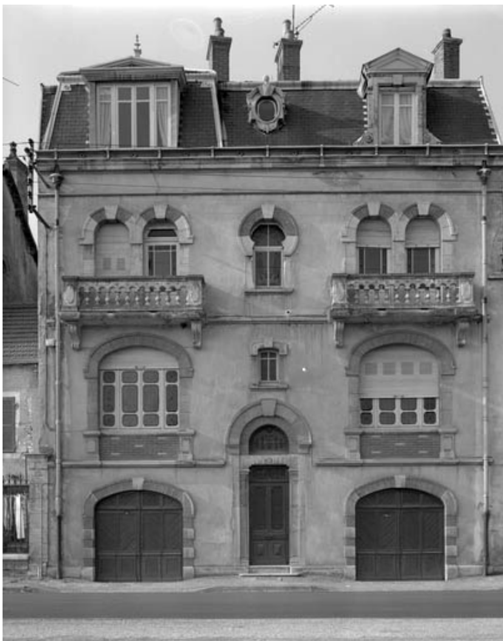
Façade antérieure de face, vue rapprochée.
