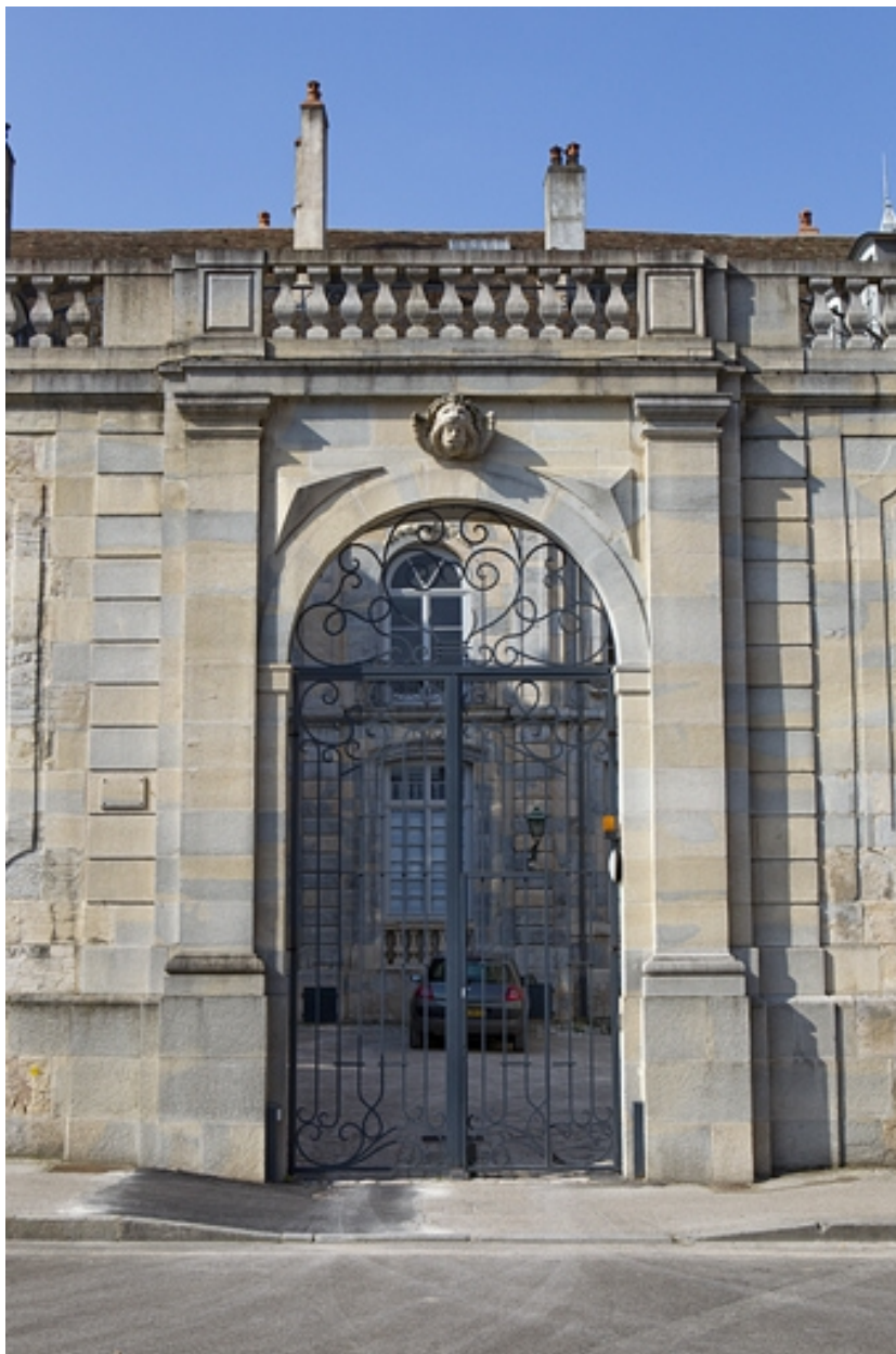
Vue d'ensemble du portail dans clôture.
