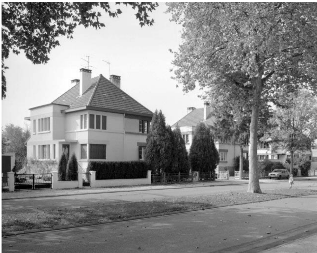
Maison identique, 32, 34 avenue Clémenceau.
