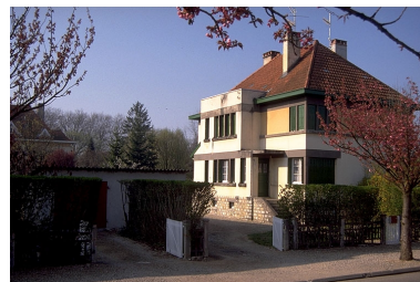
Vue générale. Phot. Laurent Poupard IVR43_19893900481ZA
