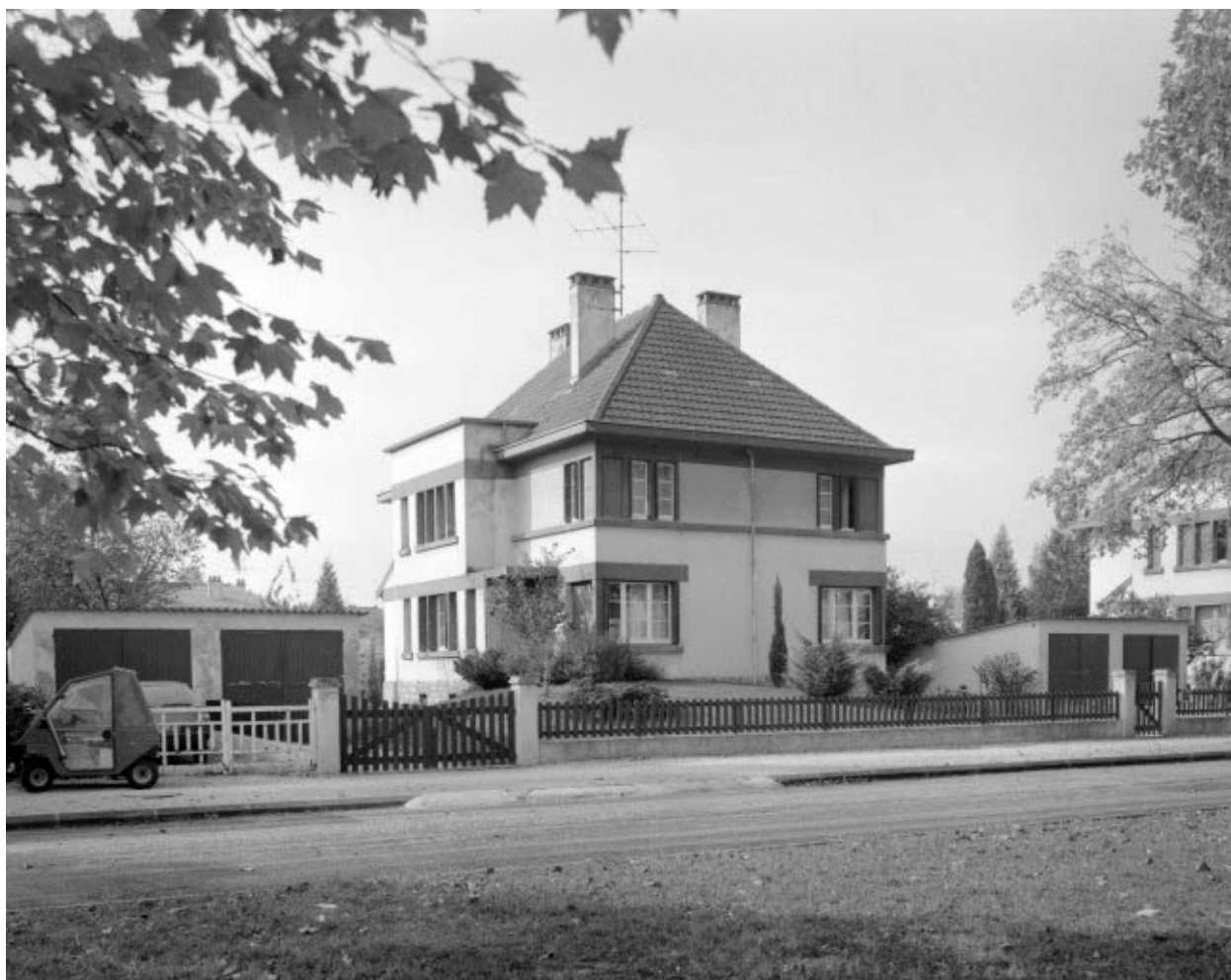
Maison identique 40, 42 avenue Clémenceau.
