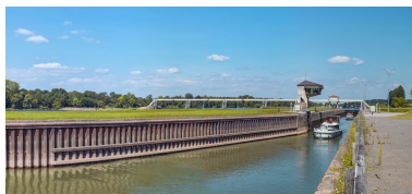
Sortie de bateaux à l'aval de l'écluse. Phot. Thierry Kuntz IVR26_20217100410NUC4A
