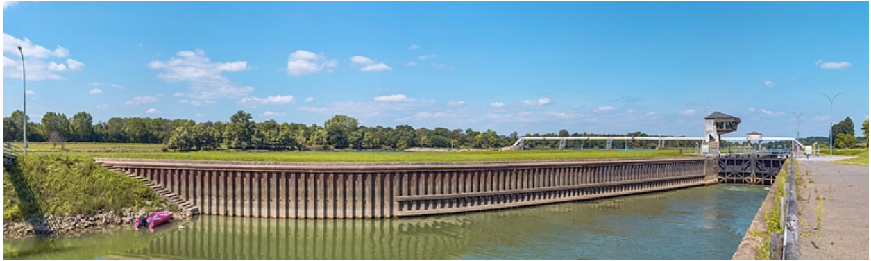
Murs-guides à l'aval du site d'écluse.
