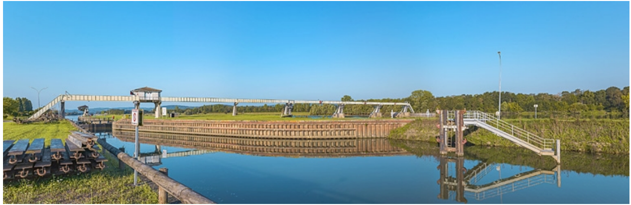
Tête amont de l'écluse.
