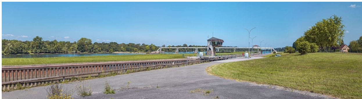
Tête aval de l'écluse.
