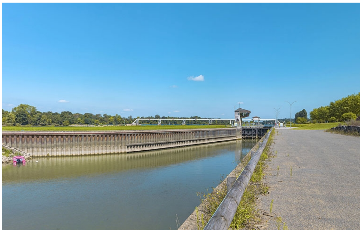
Murs-guides à l'aval du site d'écluse.
