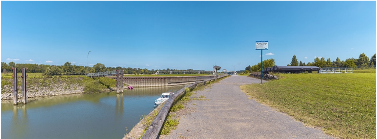
Le site d'écluse vu d'aval.
