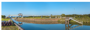
L'écluse vue d'amont. Phot. Thierry Kuntz IVR26_20217100392NUC4A
