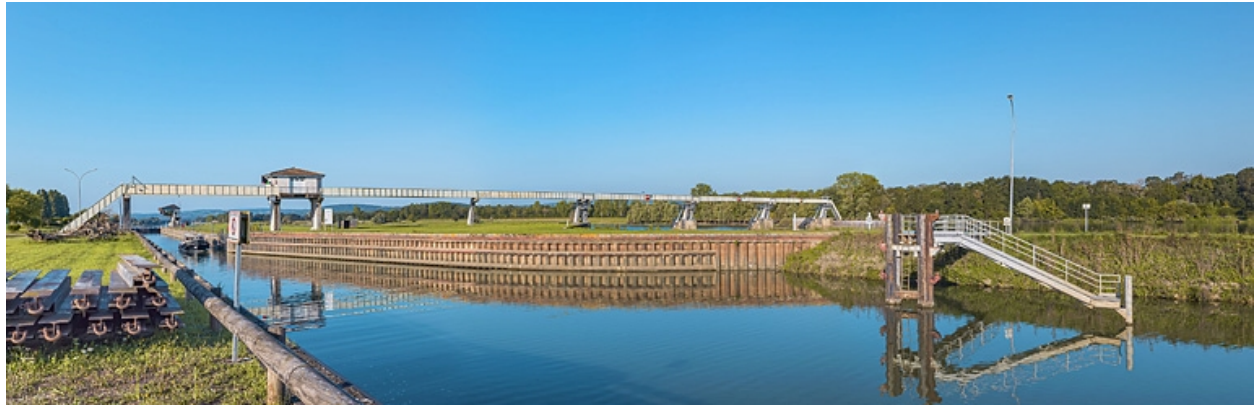
Tête amont de l'écluse.
