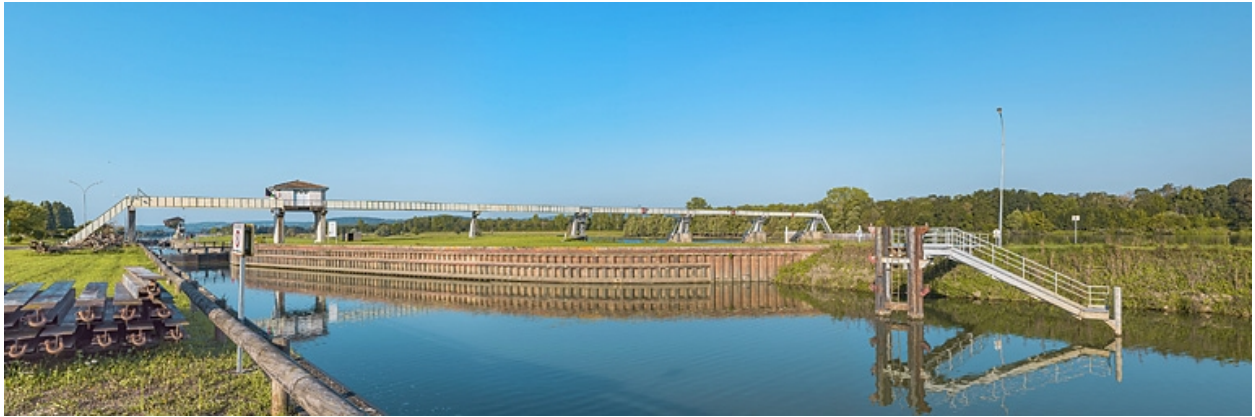
Tête amont de l'écluse.
