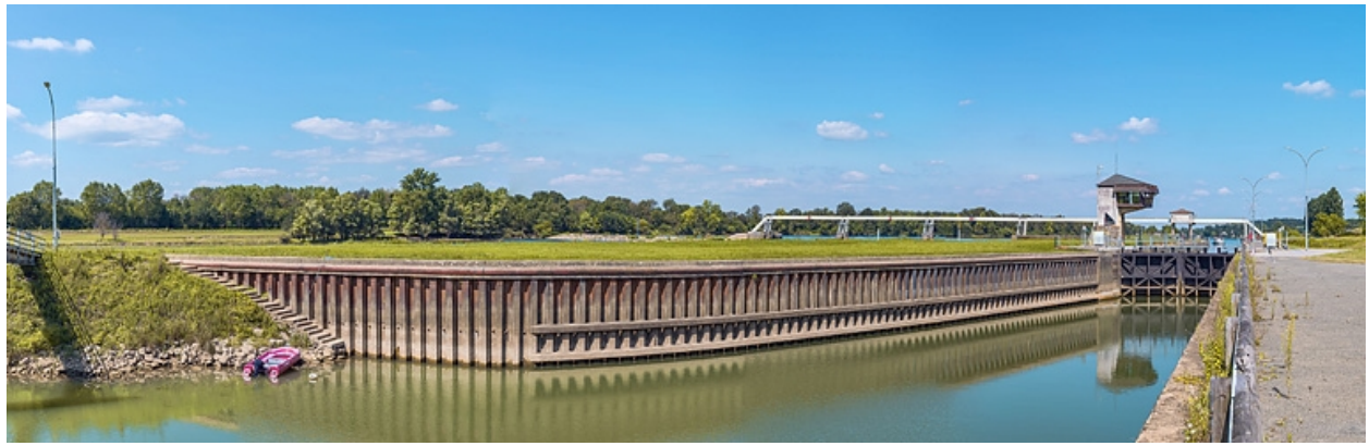
Murs-guides à l'aval du site d'écluse.
