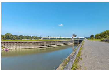
Murs-guides à l'aval du site d'écluse. Phot. Thierry Kuntz IVR26_20217100413NUC4A
