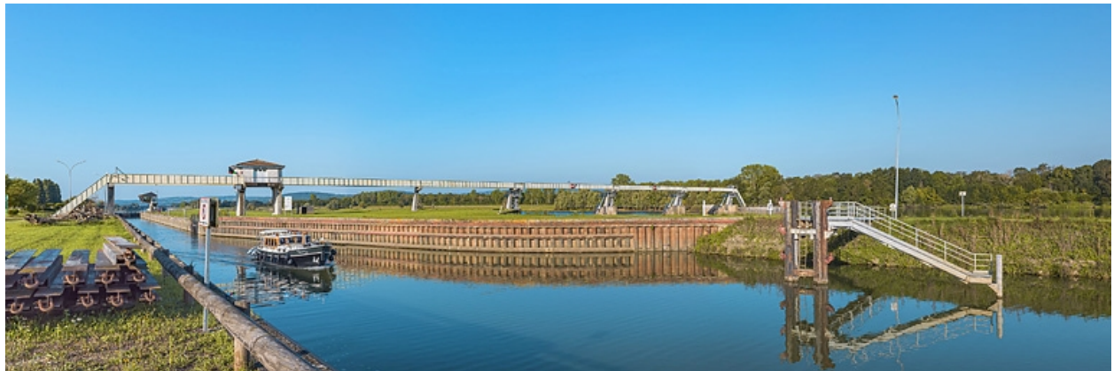
Le site d'écluse vu d'amont.
