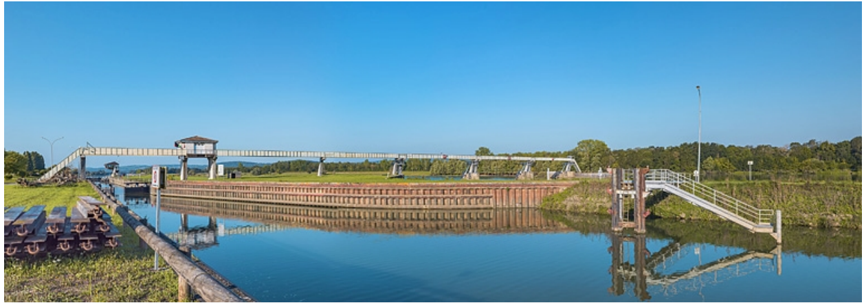
Fermeture des portes amont du site d'écluse.
