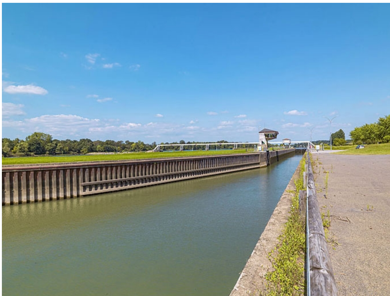
Le sas vu d'aval.
