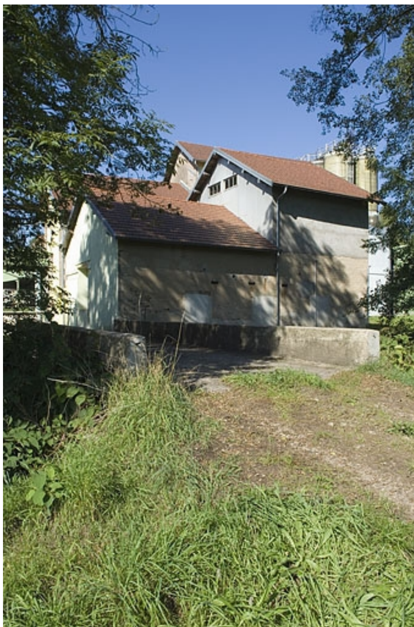
Vue du moulin depuis le sud-est.
