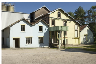
Façades occidentales du moulin. Phot. Jérôme Mongreville IVR43_20067000872NUCA
