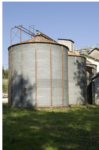
Silos métalliques. Vue depuis l'ouest. Phot. Jérôme Mongreville IVR43_20067000874NUCA
