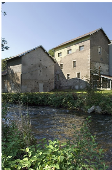
Elévation sud. Vue de trois quarts arrière.
