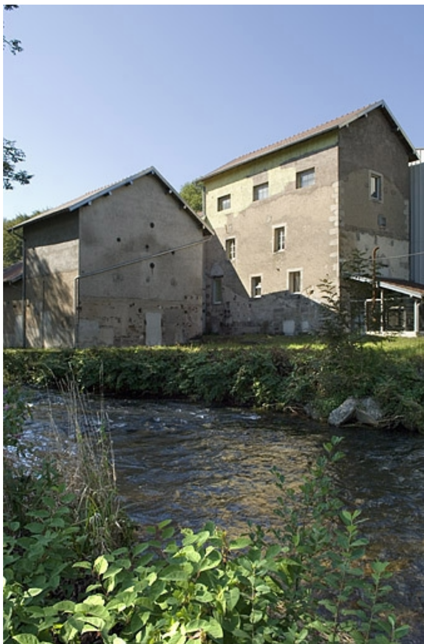
Elévation sud. Vue de trois quarts arrière.
