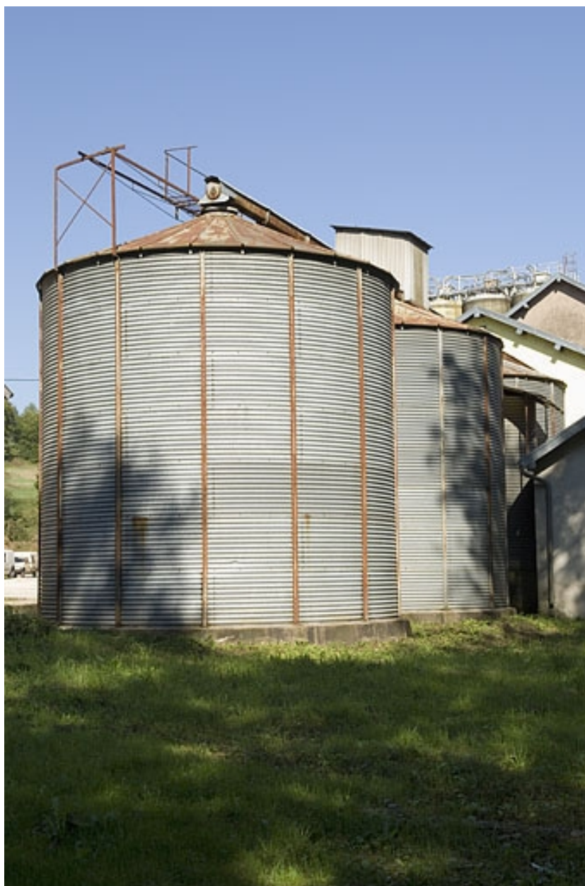
Silos métalliques. Vue depuis l'ouest.
