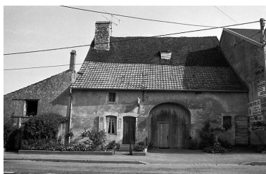
Ferme située route de Besançon. Phot. Bernard Lardière IVR43_19797000137Z
