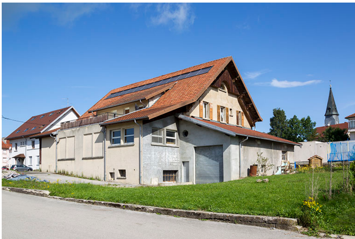
Façades postérieure et latérale droite.
