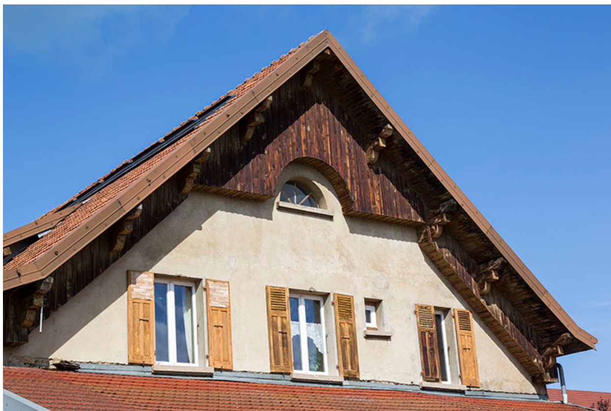
Façade postérieure : fenêtres du pignon.
