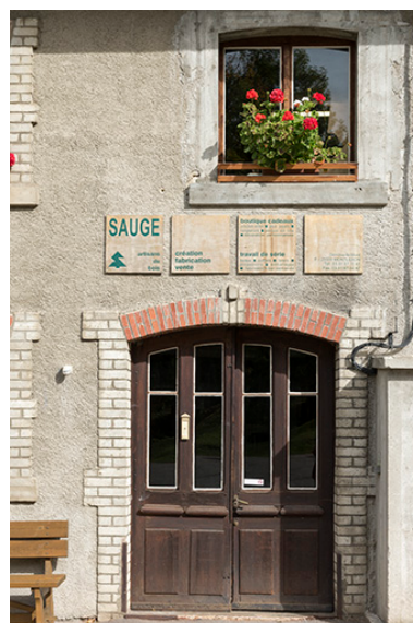
Atelier de fabrication : entrée.
