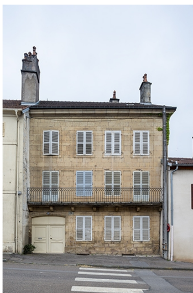
Façade antérieure. Phot. Jérôme Mongreville IVR43_20217000223NUC4A
