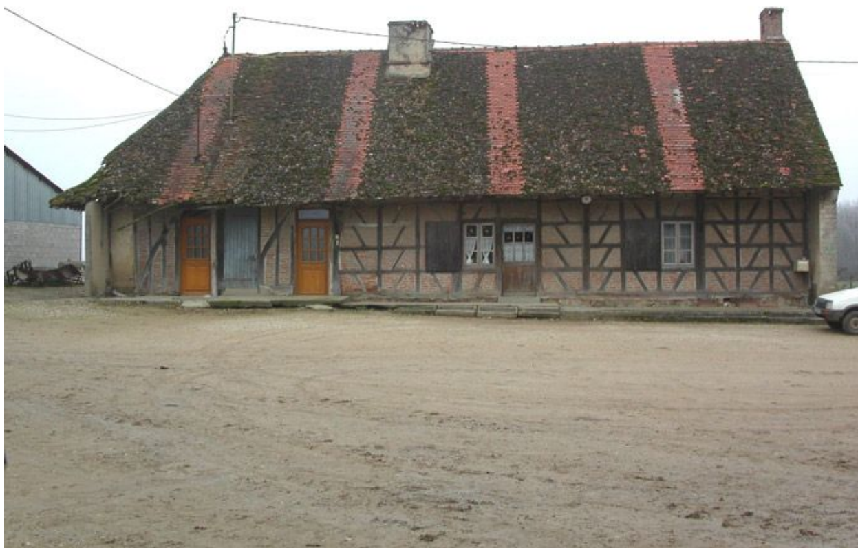
Vue d'ensemble de la façade.
