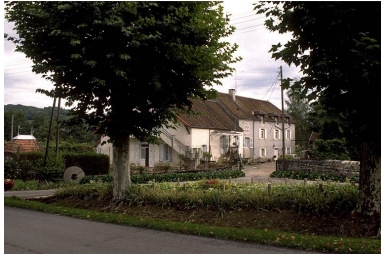
Vue d'ensemble. Phot. Jérôme Mongreville IVR43_19953900424ZA
