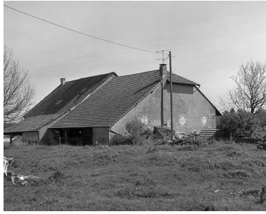
Façade postérieure et façade droite. Phot. Yves Sancey IVR43_19813900094X
