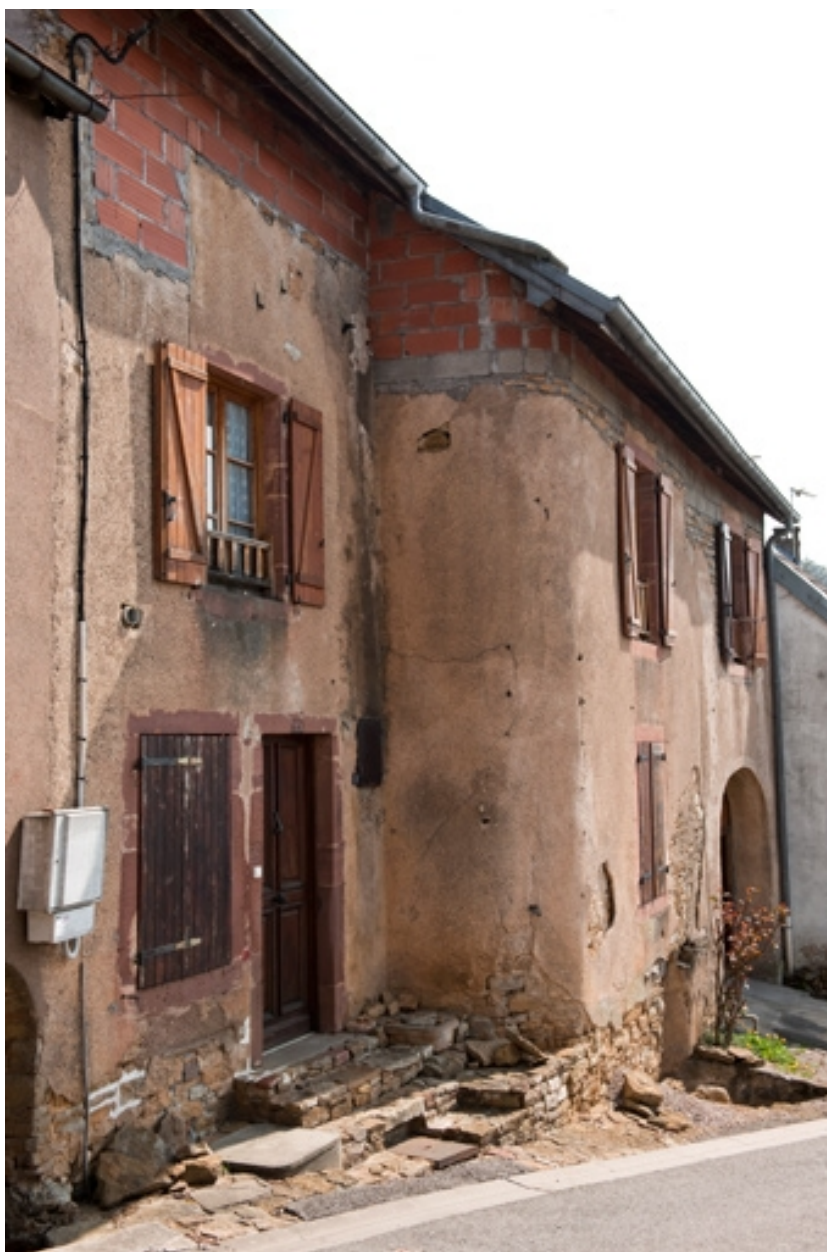
Façade antérieure, vue de trois quart gauche.
