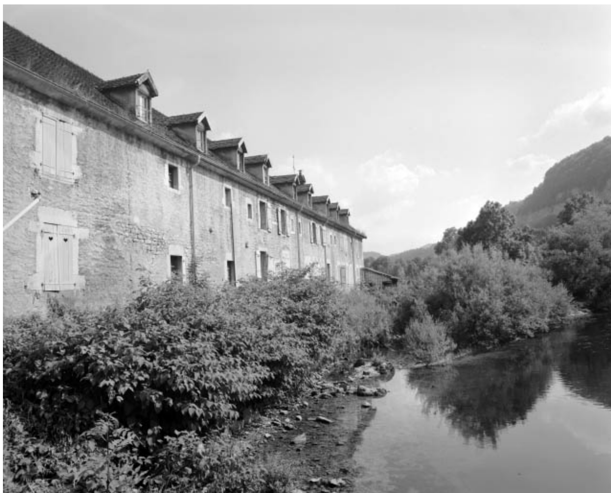
Logement d'ouvriers côté Saine.
