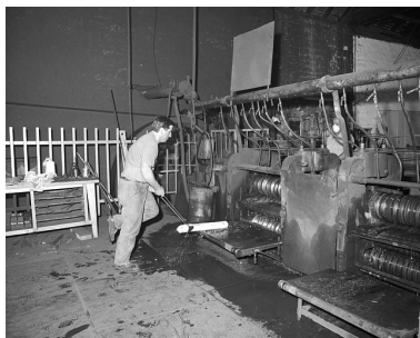
Laminoir : introduction de la billeterie en cage de dégrossis. Phot. Yves Sancey IVR43_19923900962X
