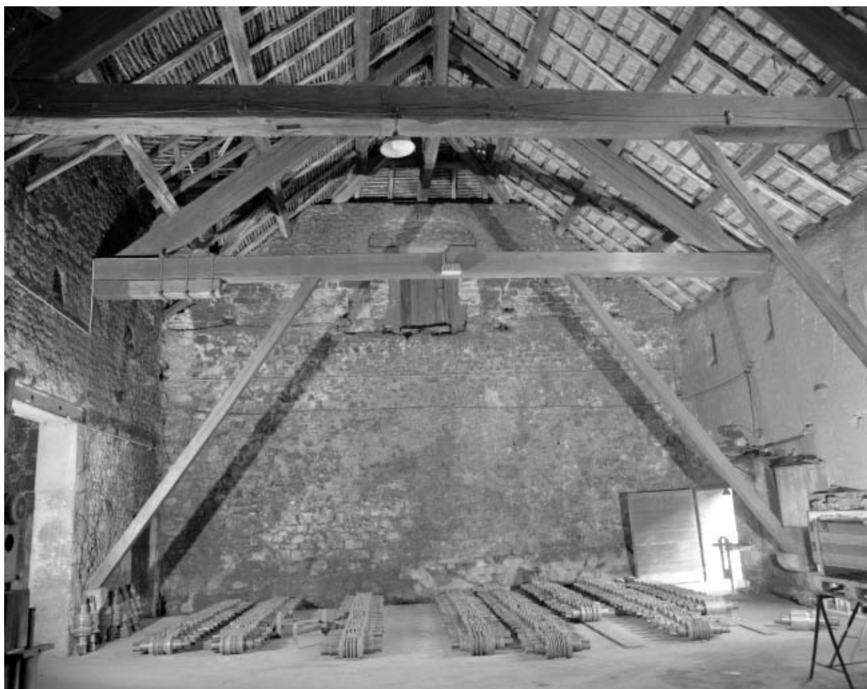
Intérieur de la pièce de stockage des cylindres (ancienne halle à charbon).
