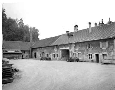
Façade postérieure de l'aile sud.
