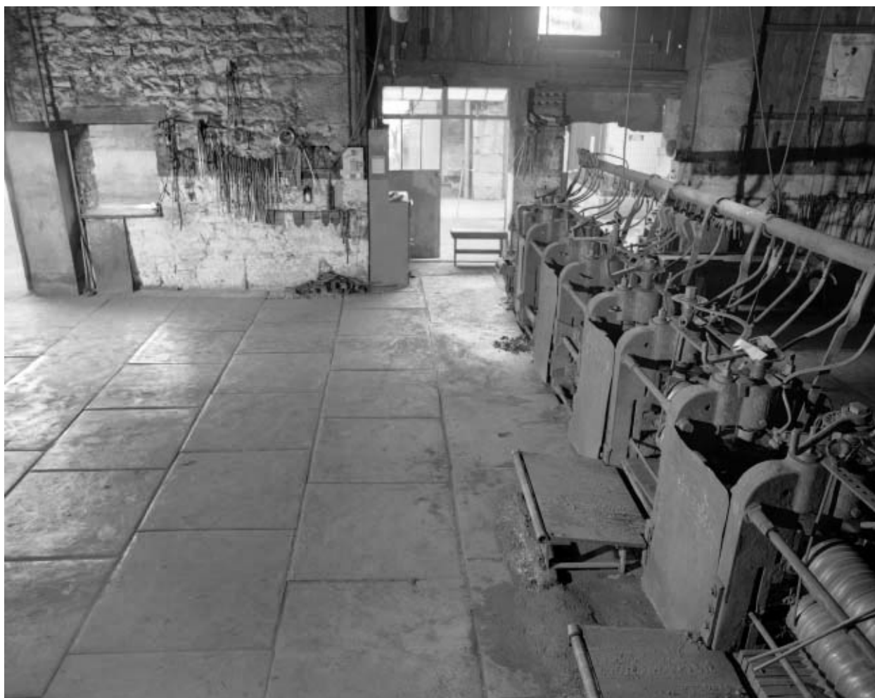
Sol du laminoir : pavage métallique.
