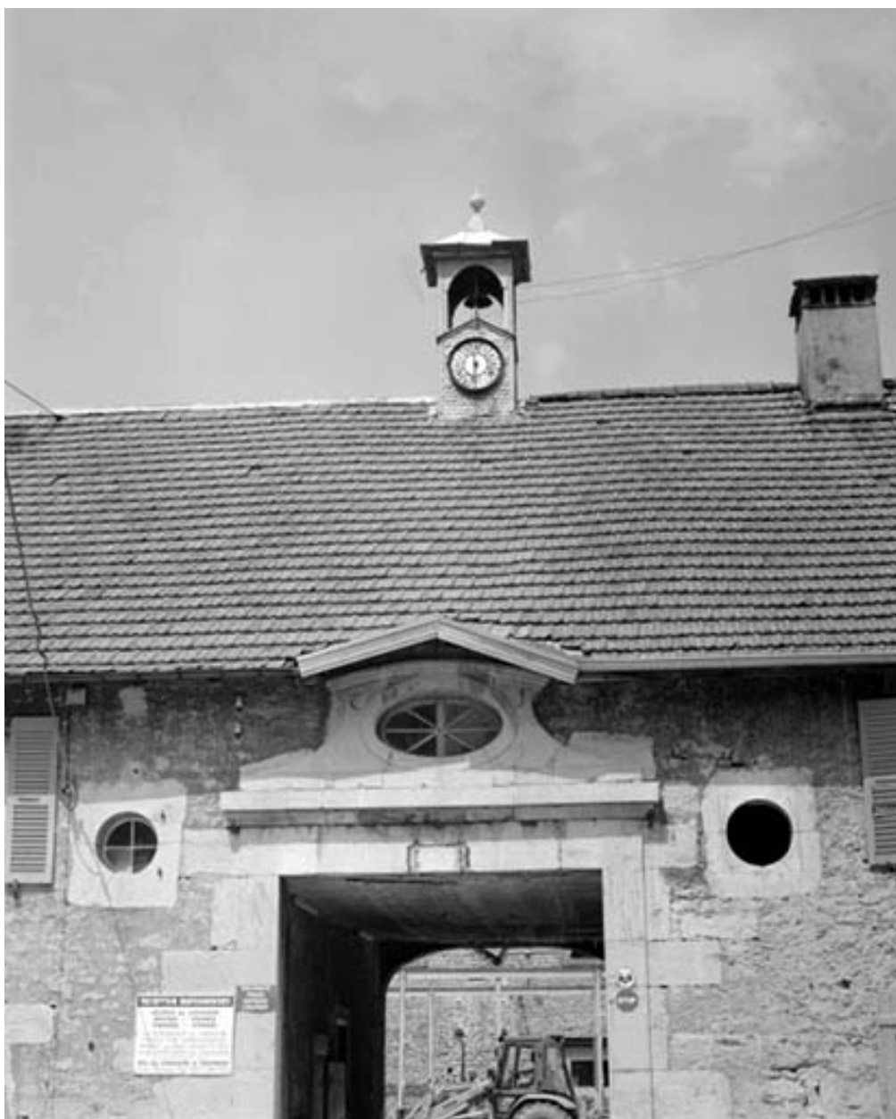
Porche d'entrée de l'usine.
