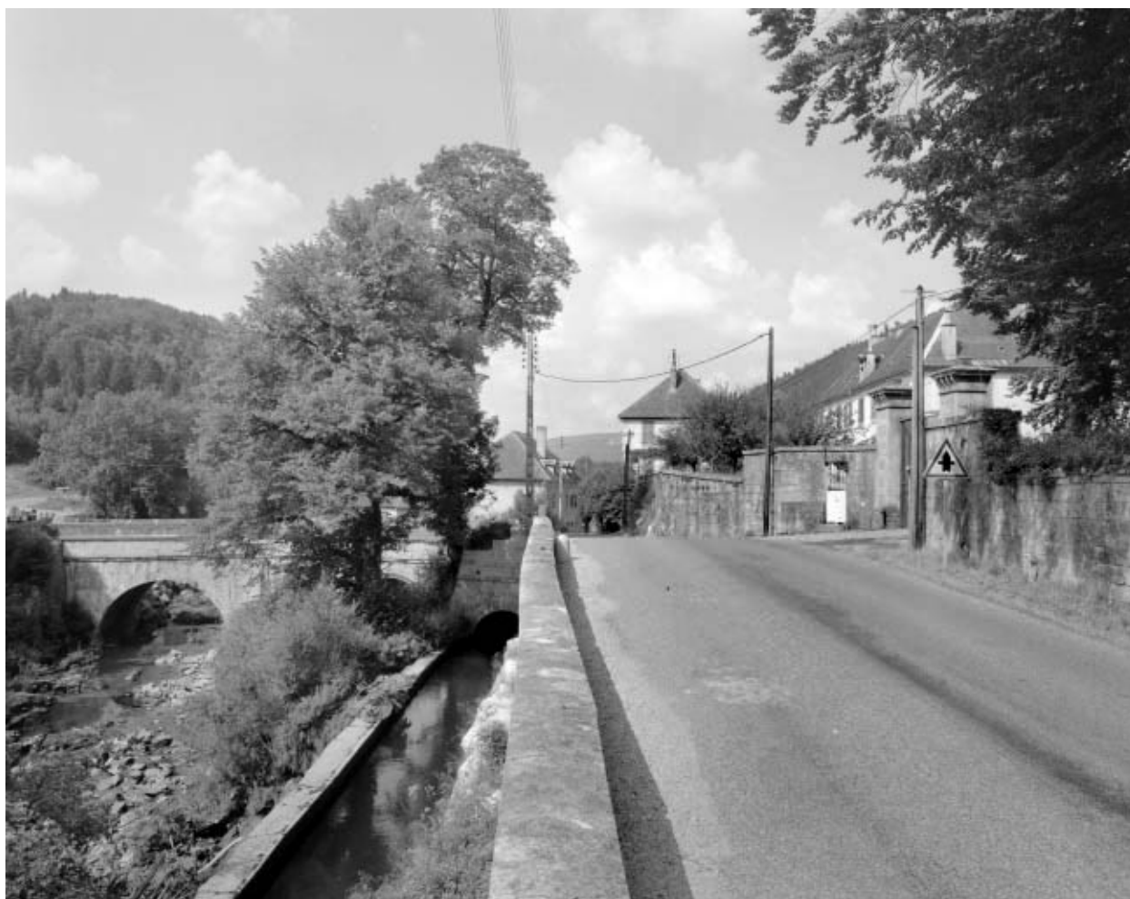
Pont et canal d'amenée, vus d'aval.
