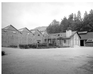
Aile nord côté cour. Phot. Yves Sancey IVR43_19923900903X
