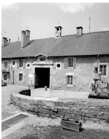
Rampe d'accès et porche d'entrée de l'usine.
