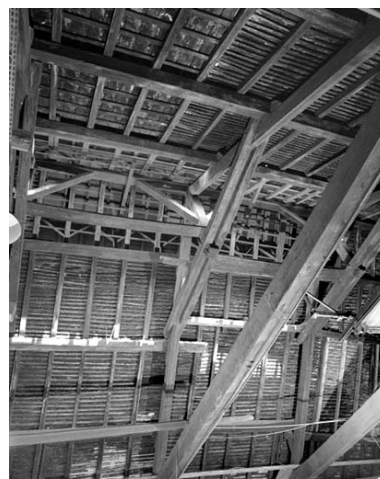
Charpente du lanterneau. Phot. Yves Sancey IVR43_19923900890X
