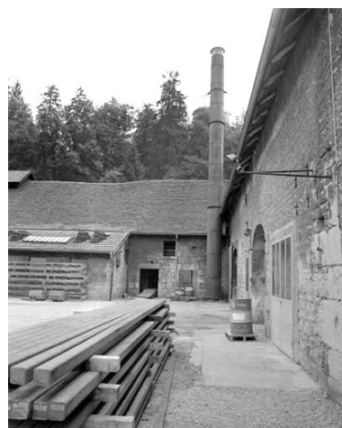
Atelier de tournage des cylindres (détruit depuis) et cheminée d'usine. Phot. Yves Sancey IVR43_19923900887X
