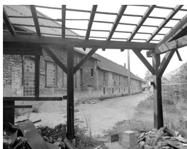
Aile ouest côté Saine. Phot. Yves Sancey IVR43_19923900919X
