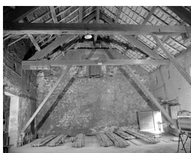
Intérieur de la pièce de stockage des cylindres (ancienne halle à charbon).
