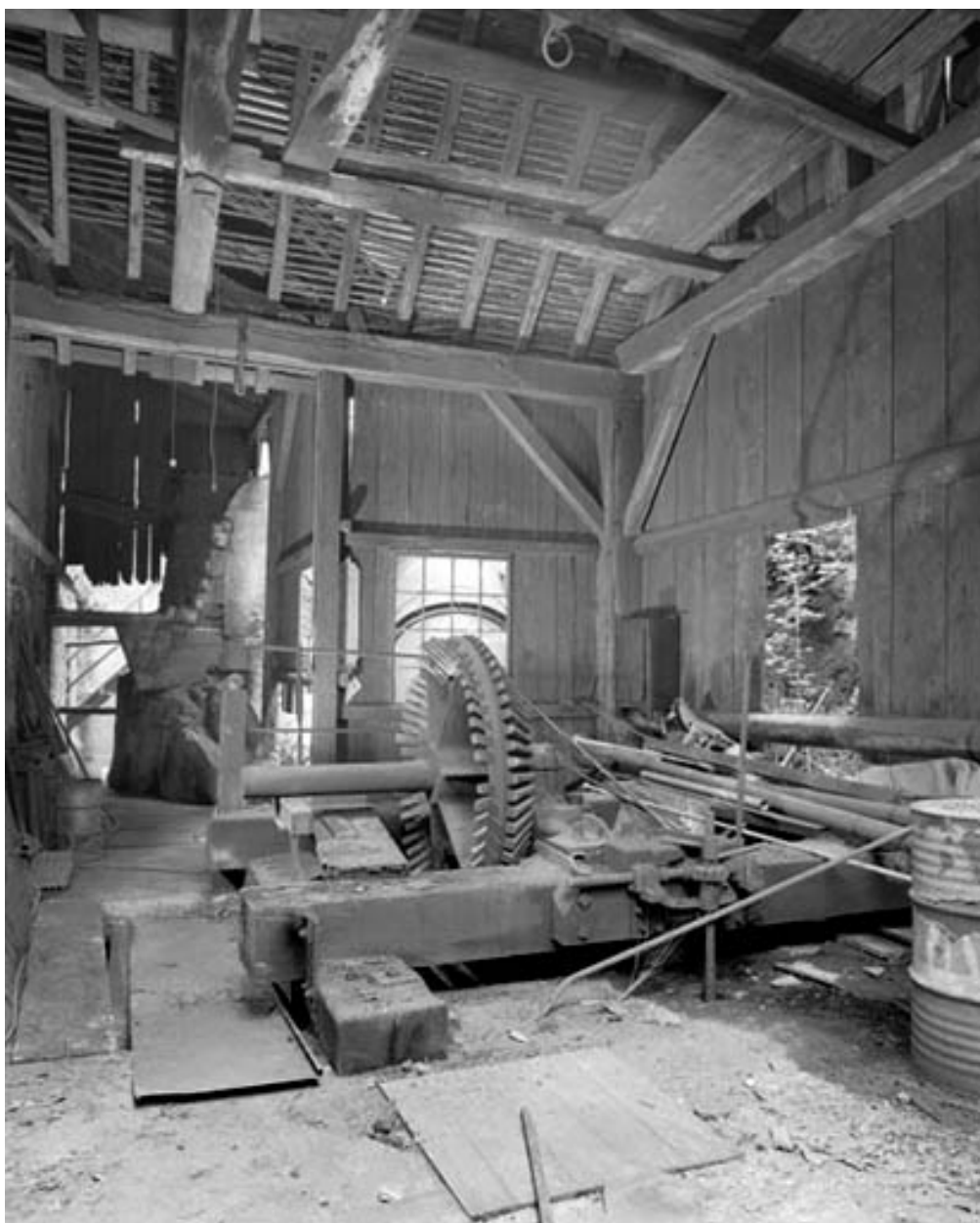
Engrenages de l'ancienne turbine du laminoir.
