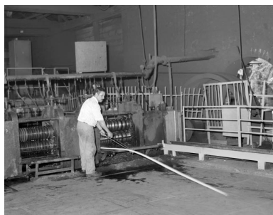
Laminoir : réception de la barre d'acier en cage de dégrossis. Phot. Yves Sancey IVR43_19923900968X
