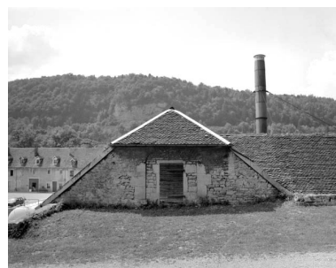
Mur pignon de l'aile sud, côté halle à charbon. Phot. Yves Sancey IVR43_19923900872X
