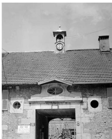
Porche d'entrée de l'usine.
