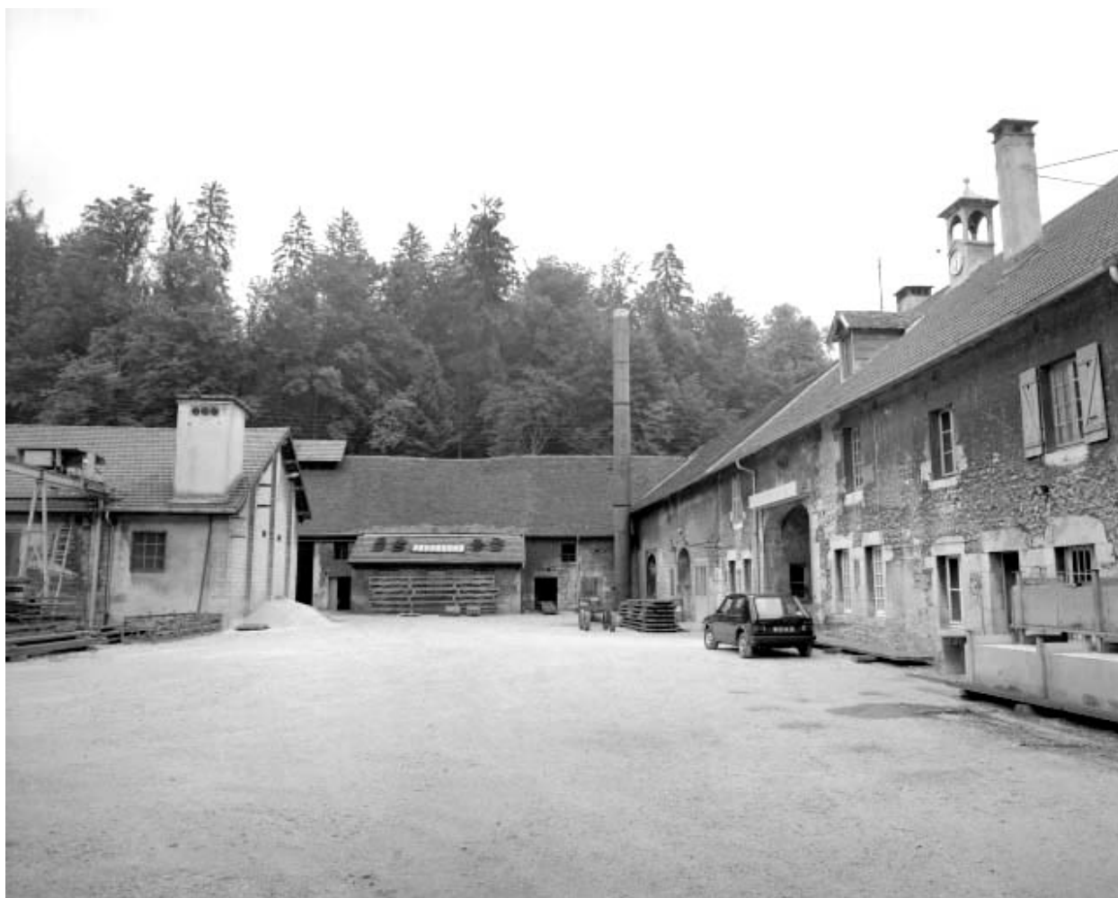
Façade sur cour de l'aile est.
