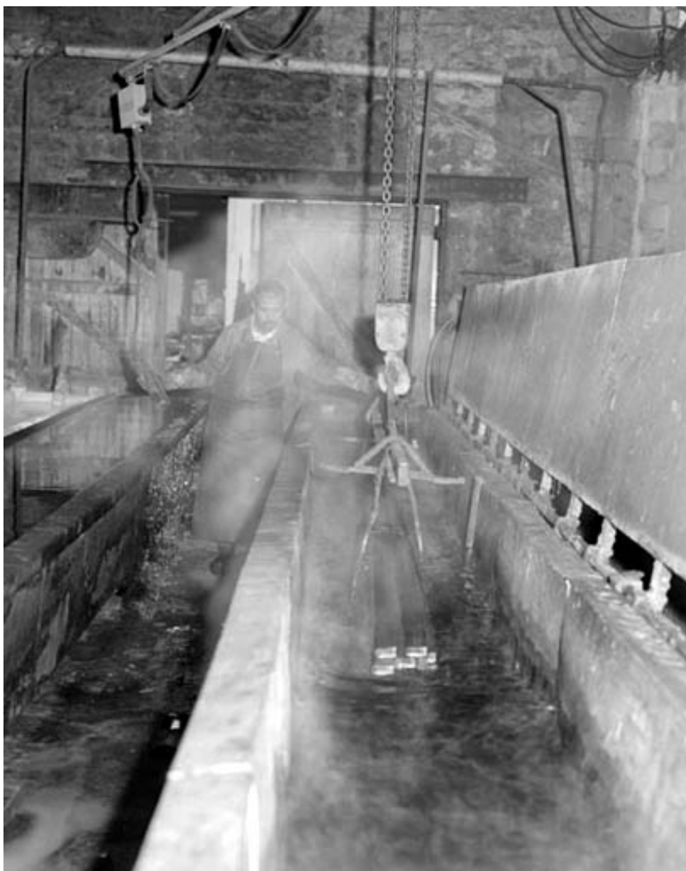
Atelier de décapage : trempage de barres dans le bain d'acide.
