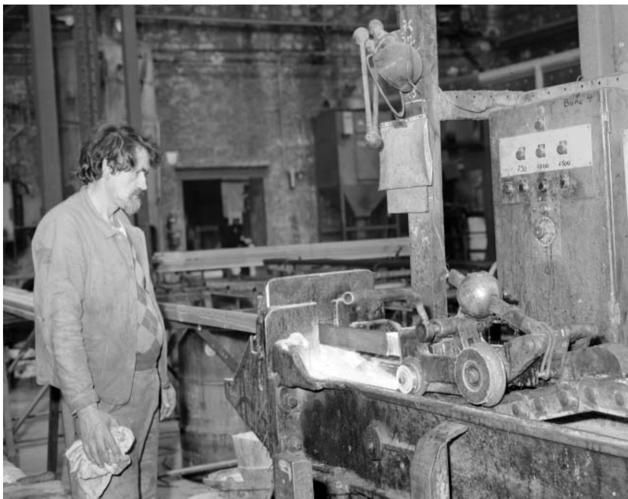
Atelier d'étirage : étirage d'une barre d'acier.
