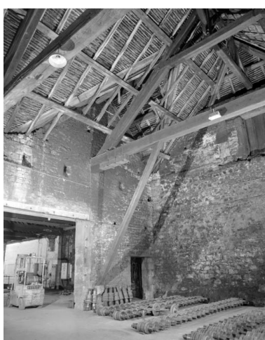
Charpente de la pièce de stockage des cylindres.
