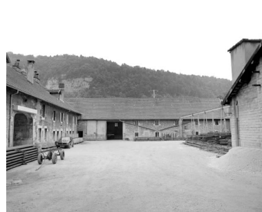
Aile ouest côté cour. Phot. Yves Sancey IVR43_19923900918X
