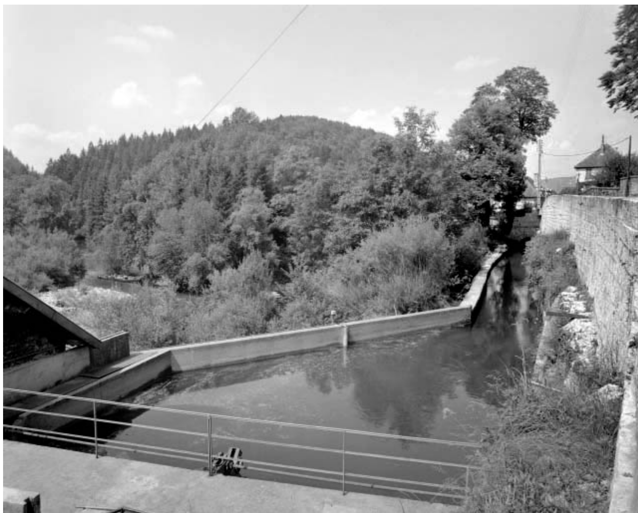
Bassin de retenue et canal d'amenée.
