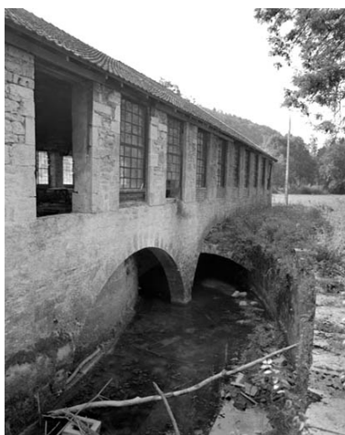
Canal passant sous la clouterie. Phot. Yves Sancey IVR43_19923900923X
