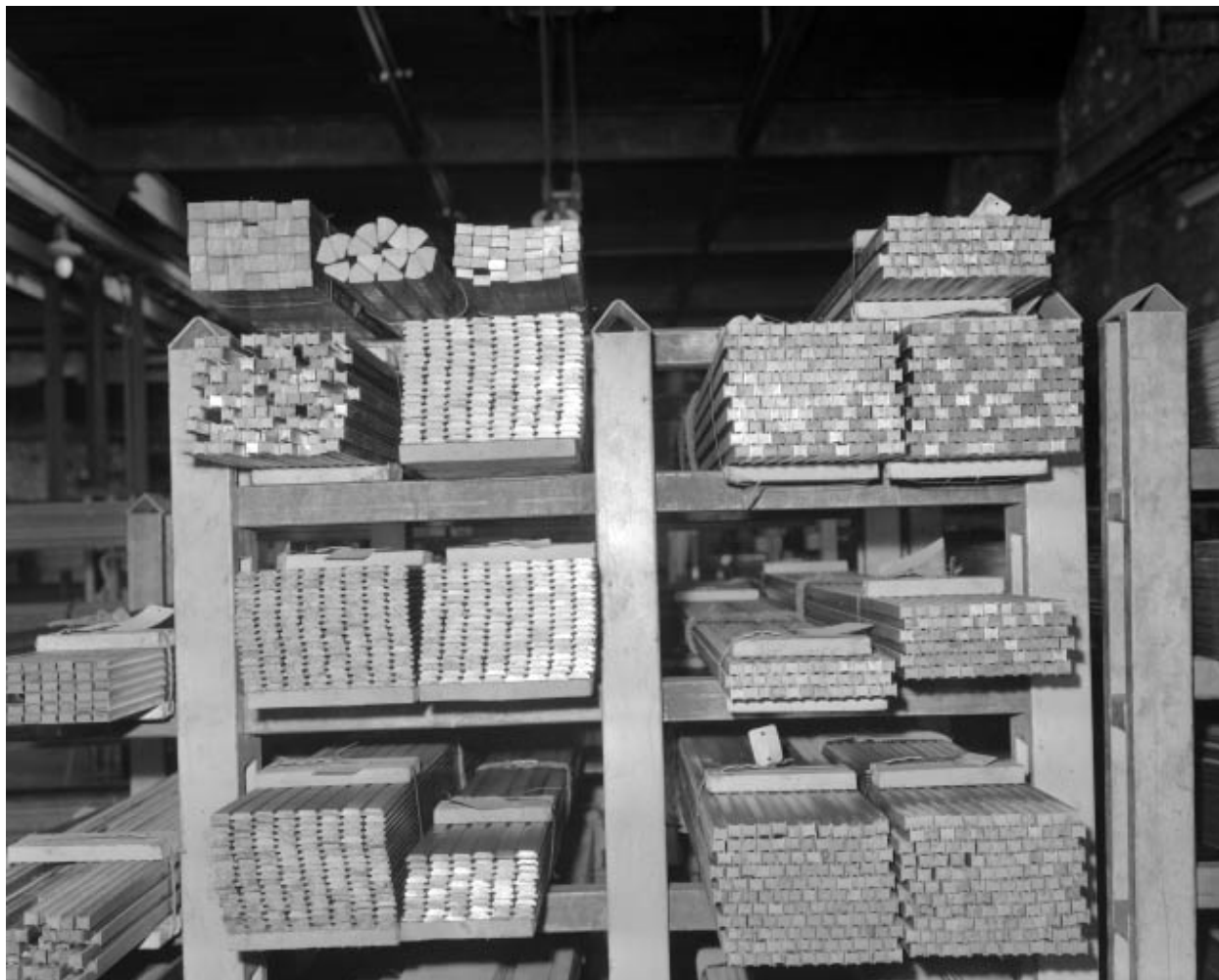
Atelier d'étirage : profilés vus de face.
