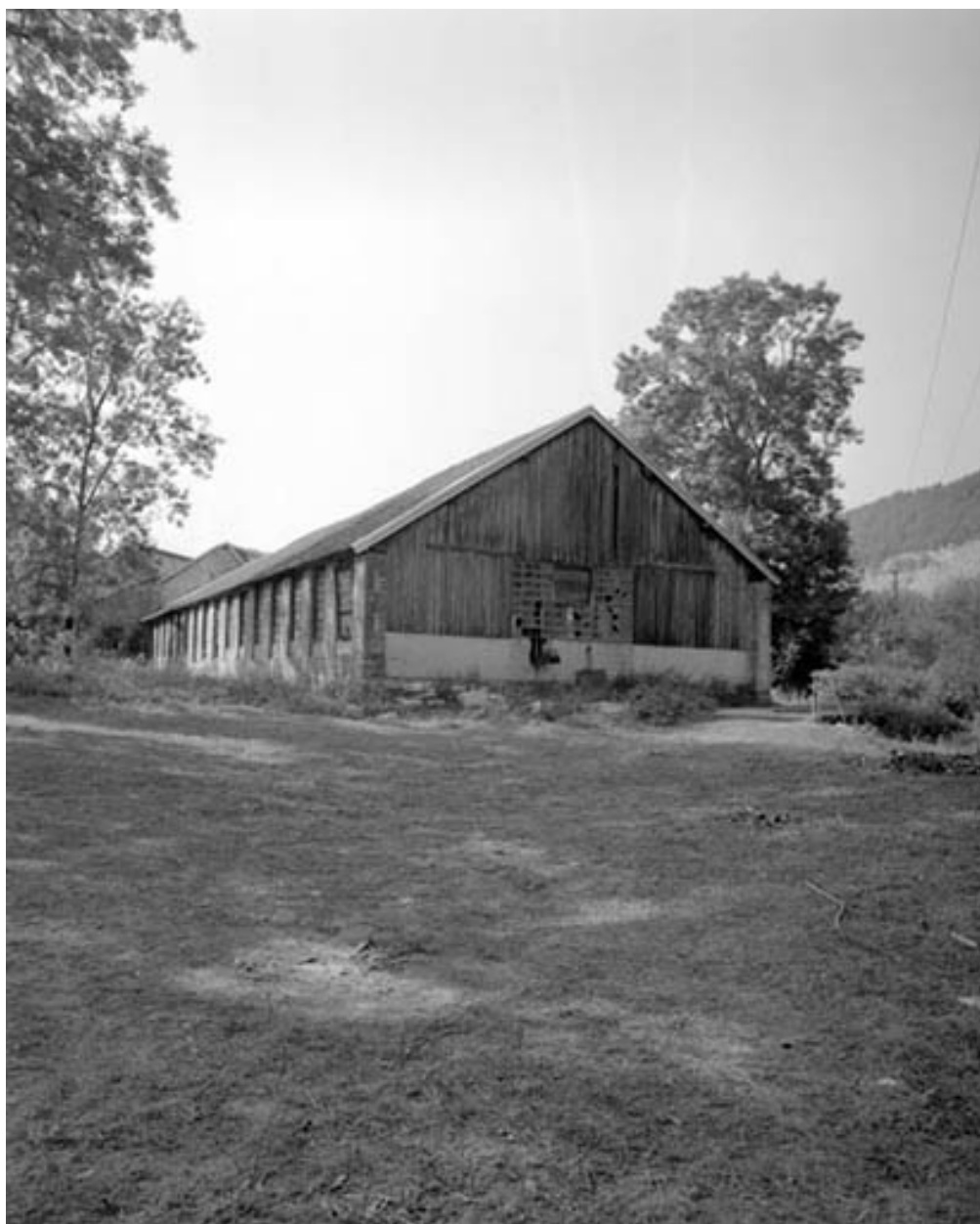
Clouterie vue du nord.
