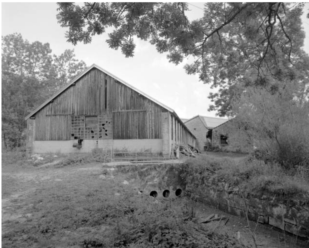
Clouterie vue du nord-ouest.
