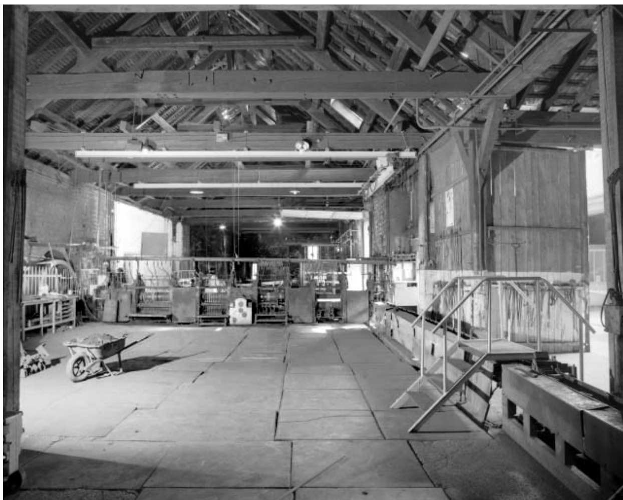
Intérieur de l'aile est depuis la centrale électrique.
