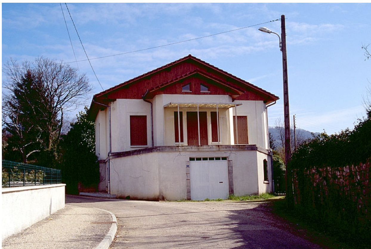
Maison métallique rue de Peroset : façade antérieure.
