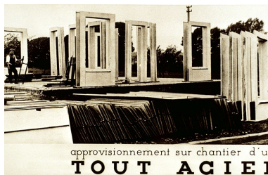
Montage d'une maison tout acier dans les années 1930 : mise en place des baies. Phot. Yves Sancey IVR43_19943900835ZA
