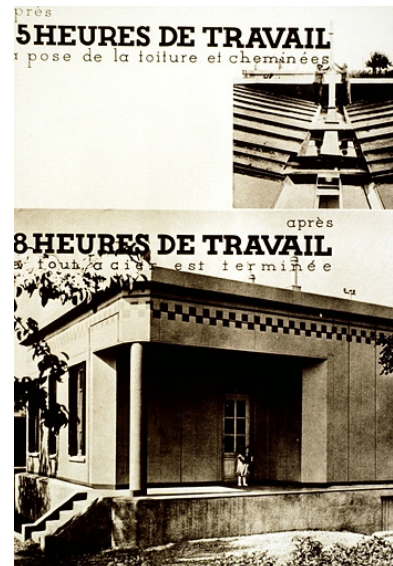
Montage d'une maison tout acier dans les années 1930 : pose de la cheminée et maison achevée. Phot. Yves Sancey IVR43_19943900837ZA
