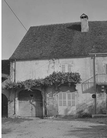
Façade antérieure, partie gauche Phot. Dominique Dominguez IVR43_19803900021X
