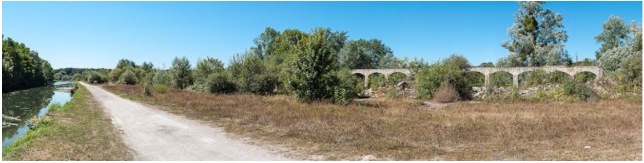
Vestiges des installations de la scierie de pierre de Chassignelles.
