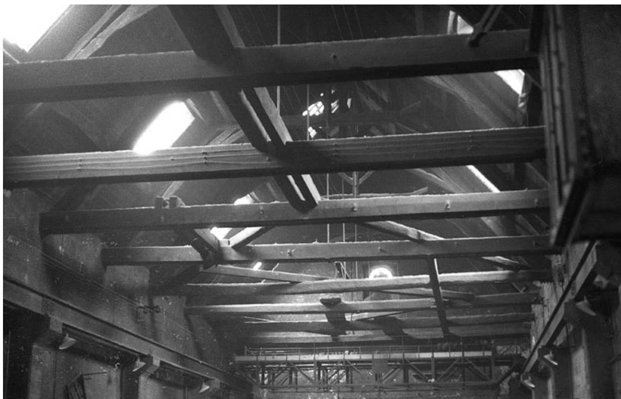
Charpente d'un atelier de fabrication.
