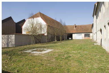
La cour de la fonderie. Phot. Jérôme Mongreville IVR43_20097000113NUC2A
