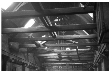
Charpente d'un atelier de fabrication. Phot. Rémi Hamelin IVR43_20107000018NUC2A
